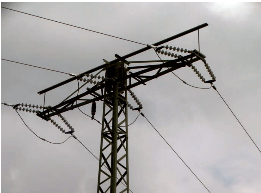
Abb. 5: Umgerüsteter Strommast. (Foto: D. Raudszus)
