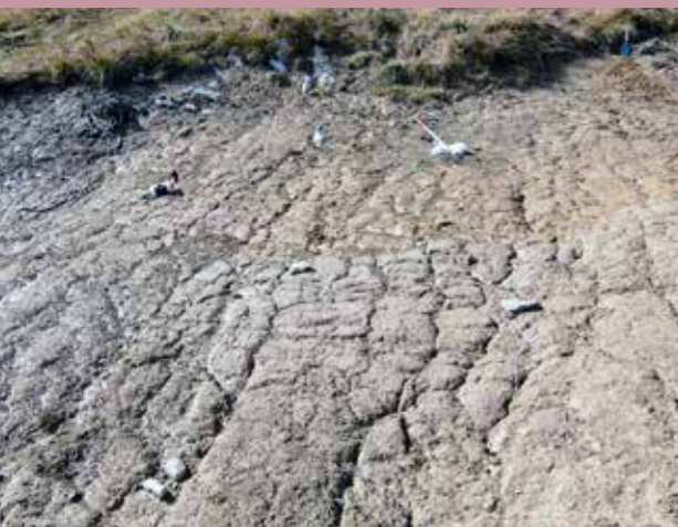
Kleinflächige Bodenabrüche können sich bei Starkregen rasch zu großen Hangrutschungen entwickeln.
