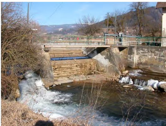
Name bzw. Lage der Anlage
