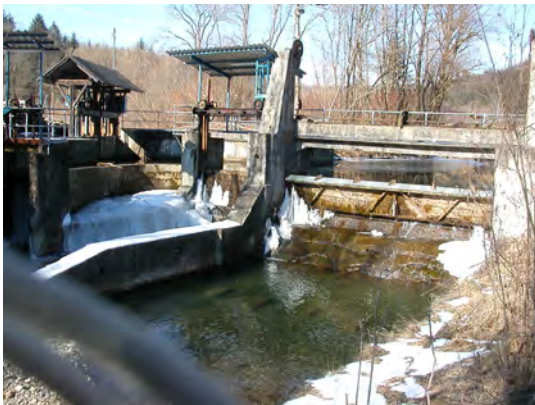
Name bzw. Lage der Anlage
