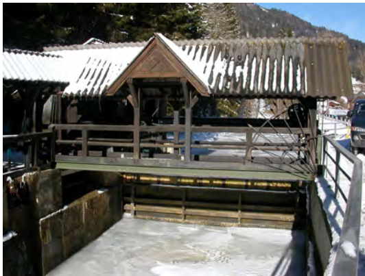
Name bzw. Lage der Anlage
