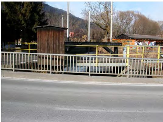
Name bzw. Lage der Anlage
