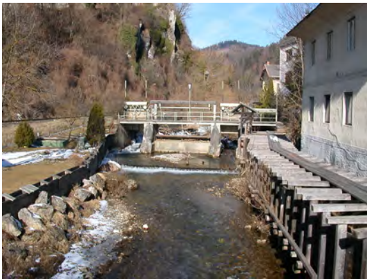
Name bzw. Lage der Anlage
