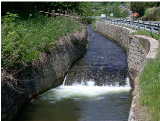
Name bzw. Lage der Anlage
