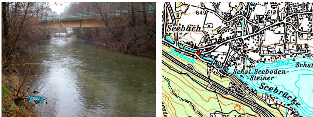
Abbildung 35: Der Millstätter Seebach im Bereich der Straßenbrücke
