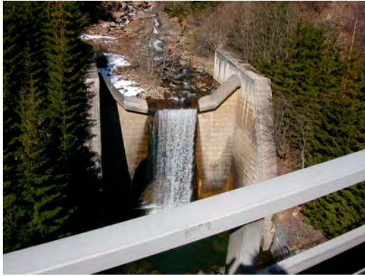
Abbildung 6: Absturzbauwerk (ca. 15 bis 20 m hoch)
