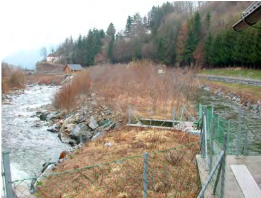
Abbildung 8: KW Glanzer mit Triebwasserkanal und Restwasserstrecke
