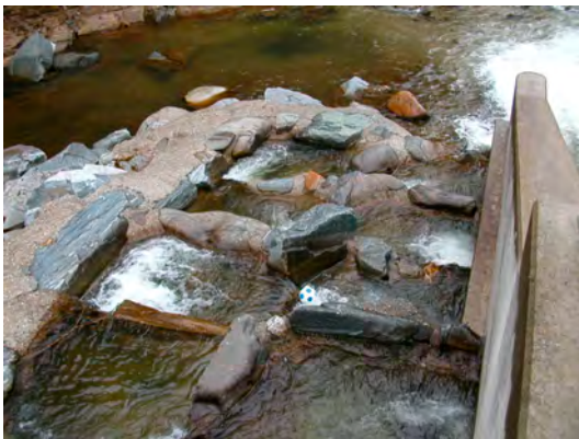
Abbildung 9: Fischaufstiegshilfe beim KW Glanzer
