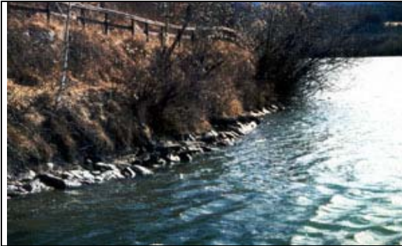
Foto 29: Uferstruktur mit kleinem Blockwurf
