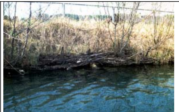
Foto 26: Mit Faschinen befestigtes Ufer
