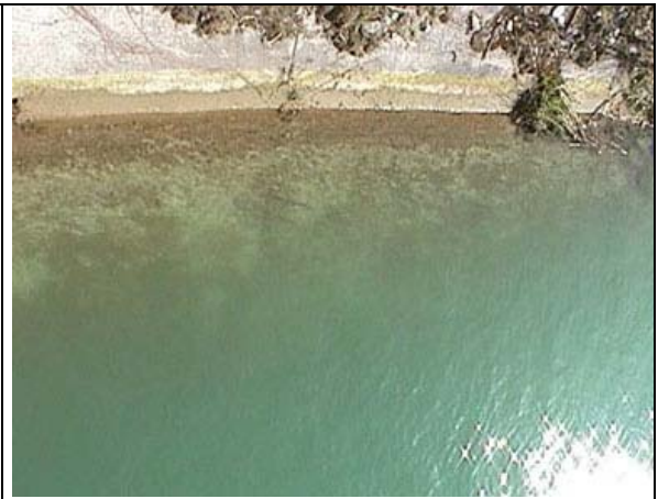
Foto 32: Sonderstruktur (X ) Asphaltdamm
