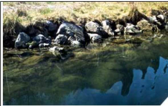
Foto 25: Uferbereich mit Blockwurfsicherung
