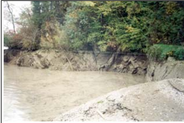
Foto 11: Merwischfelsen bei Absenkung
