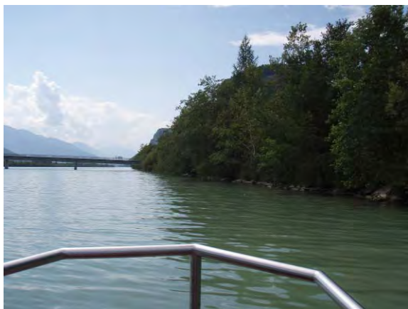
Linkes Ufer direkt unterhalb Rottensteiner Brücke.
