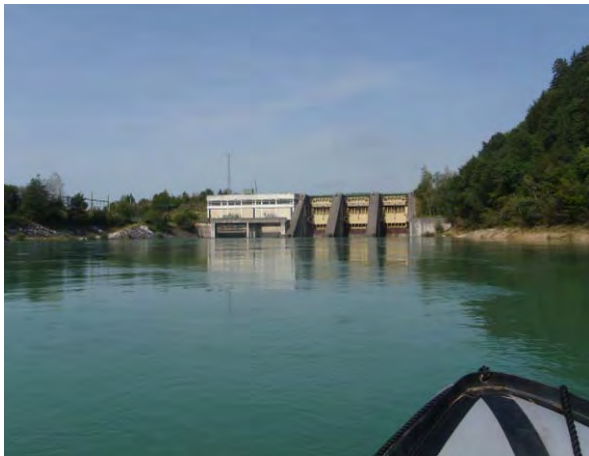
Wehr Annabrücke: Blockwurf beidseitig: kein Makrophytenbewuchs.
