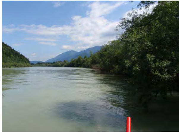
Überblicksfoto vom rechten Ufer mit Blickrichtung Glainach im Blockwurfbereich (Strukturtyp IV) unterhalb Wehr Annabrücke.
