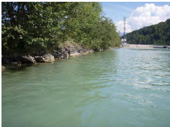
Blockwurf mit davor gelagerter Asphaltmauer ca. 100 m nach Staumauer, linkes Ufer.
