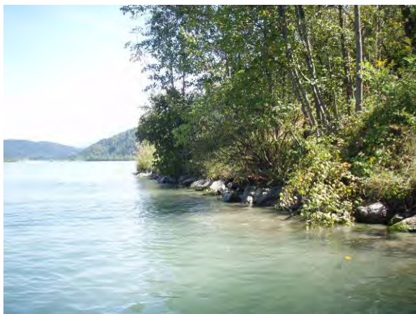
Blocksteinsicherung ca. 1100 m vor Staumauer, rechtes Ufer.
