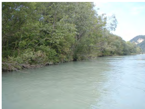
Flussab Hafen Glainach: überwachsener Blockwurf mit überhängender Vegetation, kaum Röhricht, Seggen und untergetauchte Wasserpflanzen.
