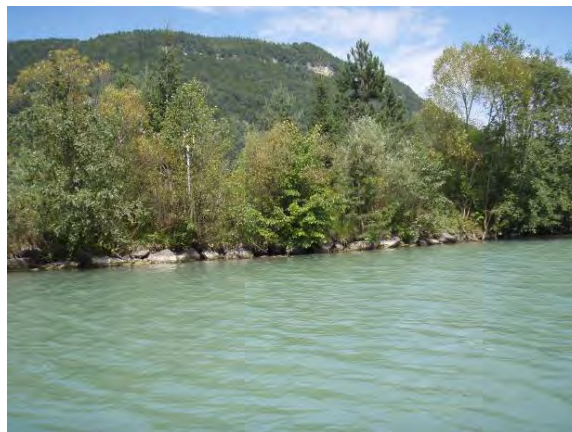
Blockwurf mit davor gelagerter Asphaltmauer bei Profil 5, linkes Ufer.
