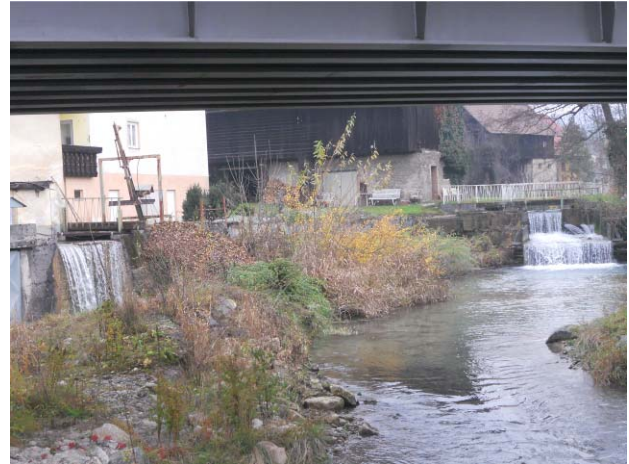
Überwasserabstürze in die Restwasserstrecke KW Tomaschitz
