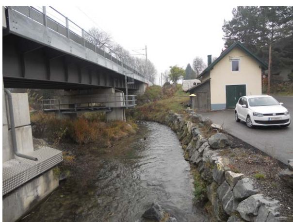
Restwasserstrecke unterhalb KW Tomaschitz, Bild 9
