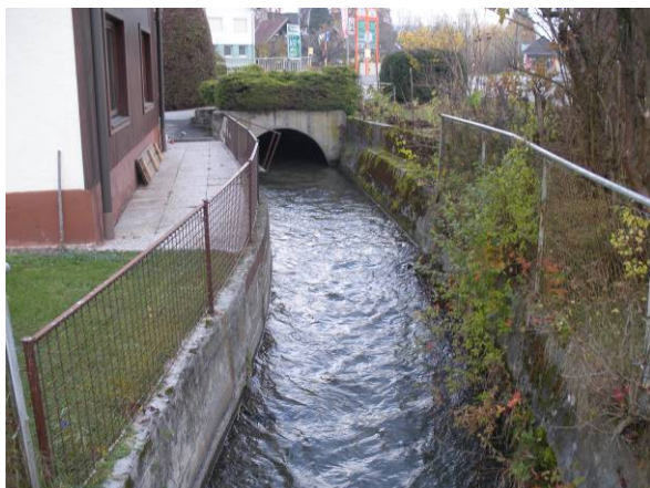
Kanalartige Ausleitung zum KW Koller
