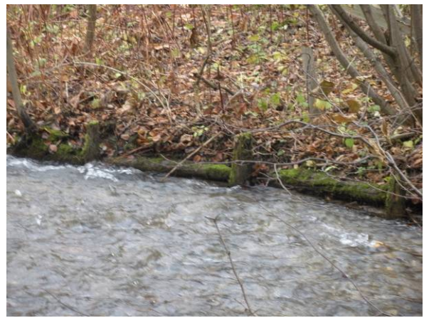
Prallhangufersicherungen aus Holz.
