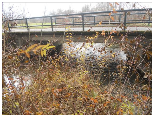
Nach Rückgabe des Triebwassers
