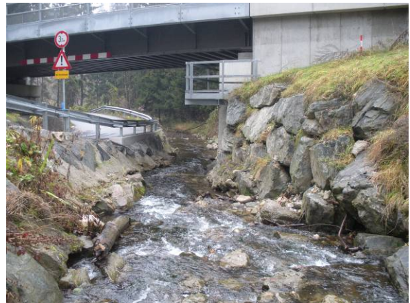
Blocksteinsicherungen an beiden Uferseiten.
