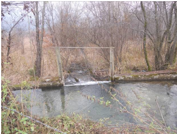
Wehr KW Oschgan, Flkm 3,56
