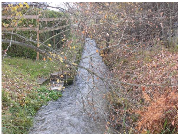
Restwasserstrecke mit linksseitiger Ufermauer.
