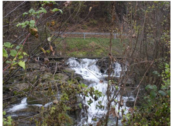
Absturz nach Auftrennung des Seebaches.
