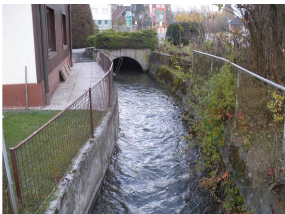
Kanalartige Ausleitung mit Ufermauern.
