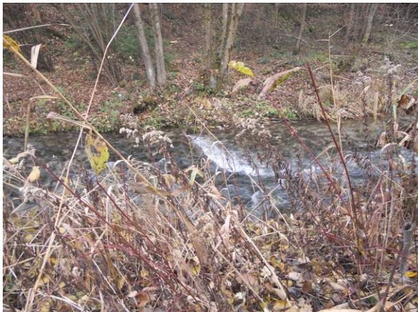
Sohlschwelle bei Flkm 1,8
