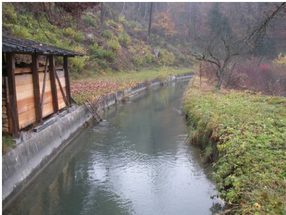
Mühlbachkanal mit Ufermauer.
