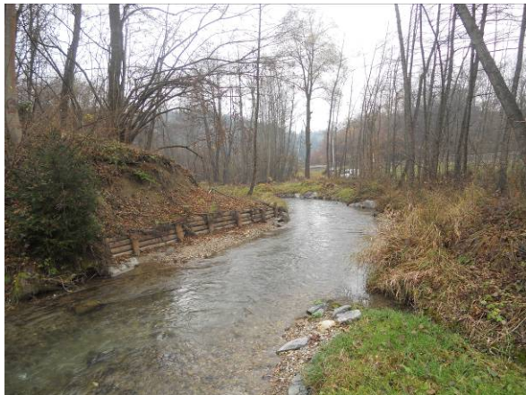
Ufersicherung aus Holz links bzw. Blocksteinen rechts- strukturgebend Alte rampenartige Wehranlage mit Kolkbildung
