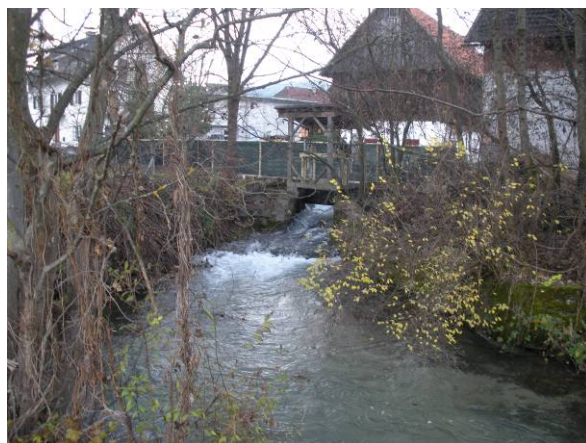
Wasserrückführung KW Koller bei Flkm 5,75.
