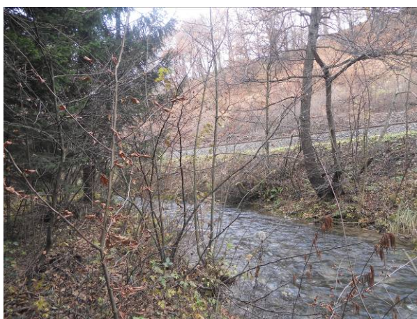
Bahndamm am rechten Ufer
