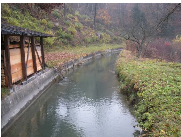
Mühlbachkanal mit Ufermauer.
