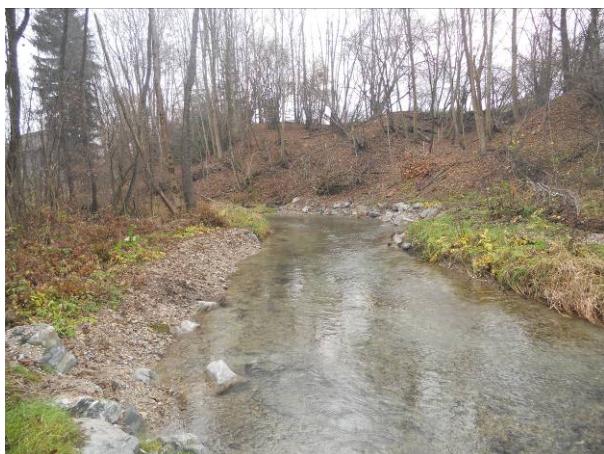
Bereich Flkm 2,3 Blick flussab
