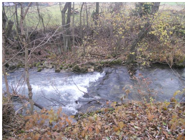
Sohlschwelle als Fremdmaterialeintrag
