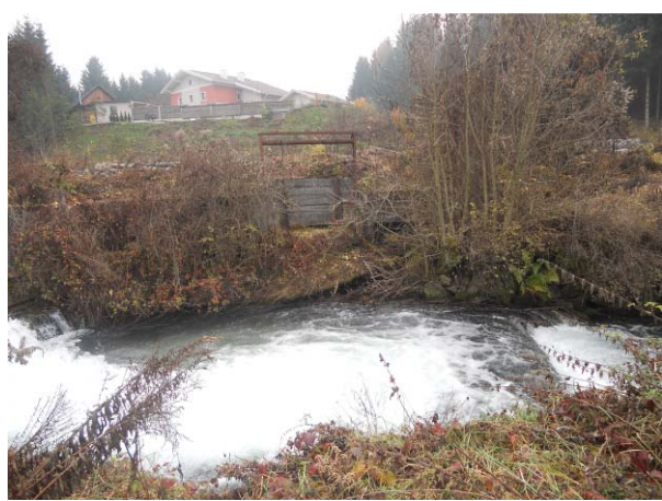
Alter Wasserweg und weitere Sohlschwelle, Flkm 1,99
