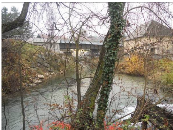
Restwasserstrecke KW Tomaschitz mit Überwasserrückgabe, Bild 5
