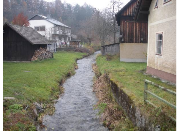
Fehlender Uferbegleitstreifen – Blickrichtung flussauf bei Flkm 0,4.
