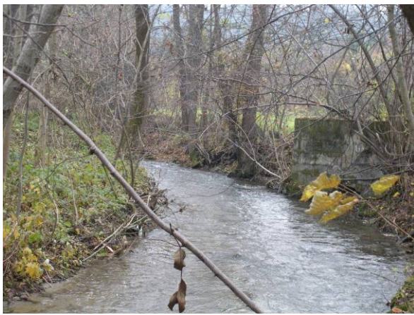
Reste einer alten Ufermauer - Blickrichtung flussauf.
