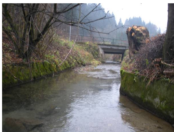
Blickrichtung flussab RW-Strecke
