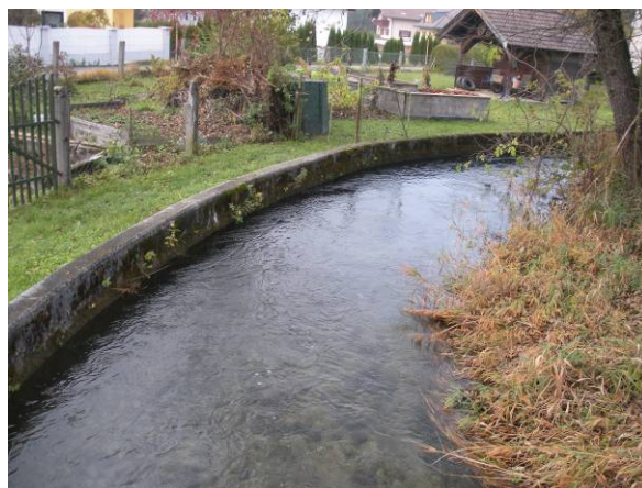
Hart verbauter Kanal - Blickrichtung flussab
