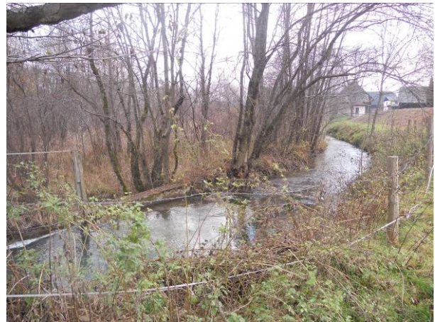
Triebwasserkanal (Mühlbach 3) vom KW Oschgan
