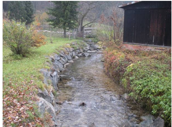
Anthropogen überformte Böschung.
