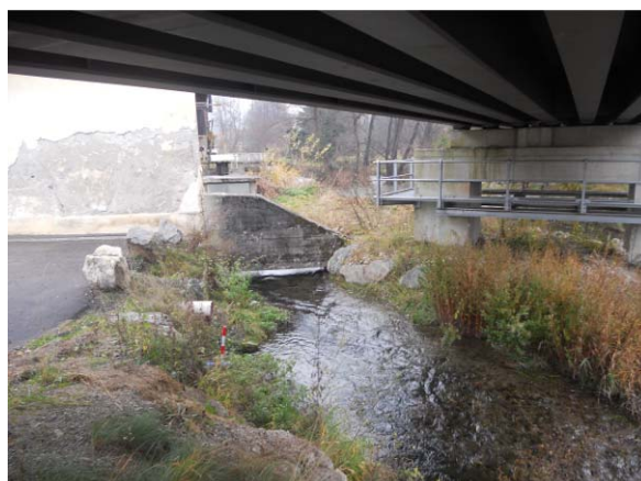
unterhalb KW Tomaschitz, Bild 6
