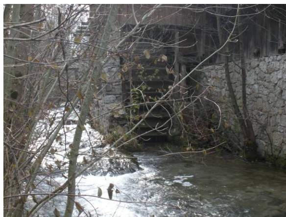
Stillgelegte Mühle bei Flkm 1,06
