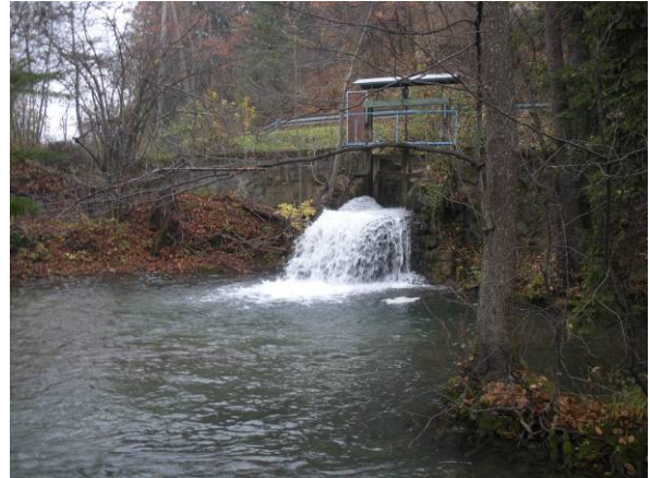
Bei erhöhter Wasserführung besteht eine teilweise Wasserrückleitung vom Kanal in die Restwasserstrecke.
