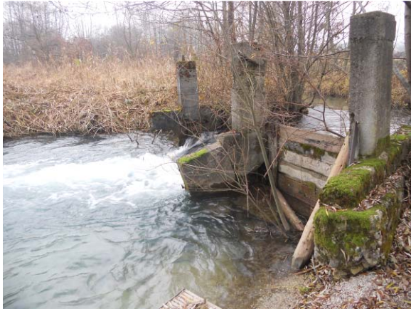
Alte Wehranlage, Flkm 3,0
