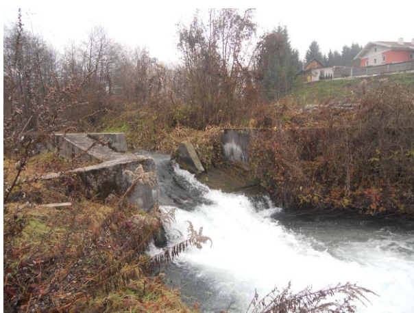
Alte Wehranlage mit rampenartigem Absturz, KW nicht in Betrieb, Flkm 2,0
