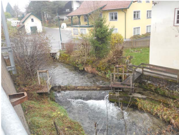
Wehr unterhalb KW Tomaschitz - Maschinenanlage, nicht im Wasserbuch enthalten - Wehranlage mit Sohlschwelle, Bild 11
