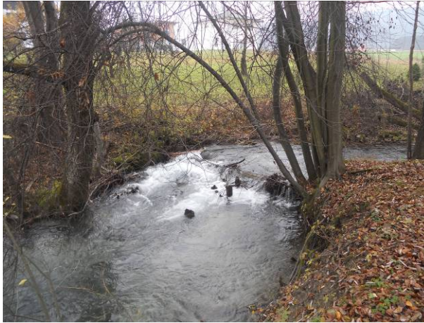
Sohlschwelle aus Holz als naturnahe Verbauung und zugleich Fremdeintrag
