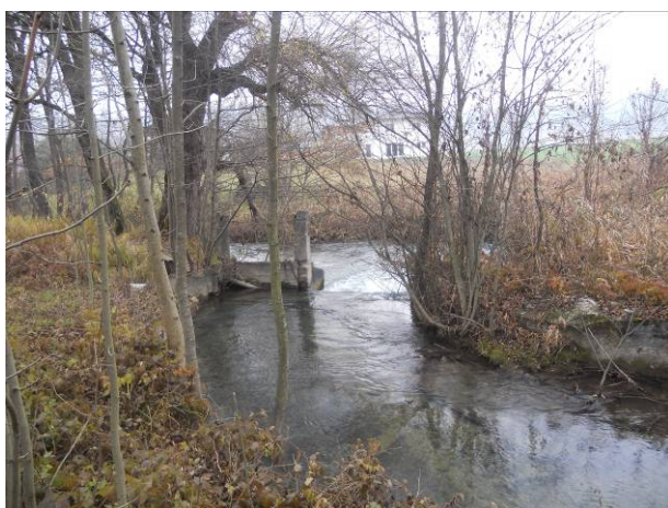
Bereich oberhalb alter Wehranlage, Flkm 3,0
