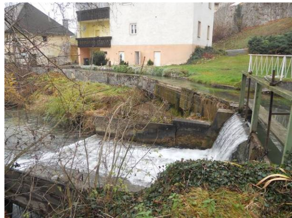
Triebwasserkanal mit Überwasserabfluss KW Tomaschitz, Bild 2
