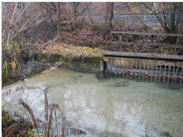
Wehr bei Flkm 1,45
