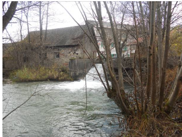
Krafthaus und Überwasserabfluss
