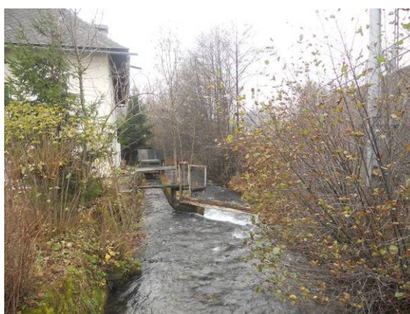
Wehr unterhalb Maschinenanlage, KW Tomaschitz - nicht im Wasserbuch enthalten, Bild 10
