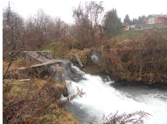
Ufersicherung aus Holz links bzw. Blocksteinen rechts- strukturgebend Alte rampenartige Wehranlage mit Kolkbildung
