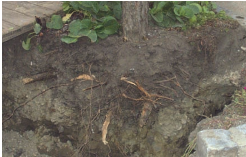
Massive Wurzelschäden durch Grabungsarbeiten.
