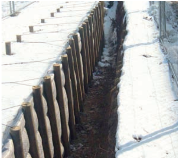
Wurzelvorhang zur Begrenzung der späteren Baugrube.
