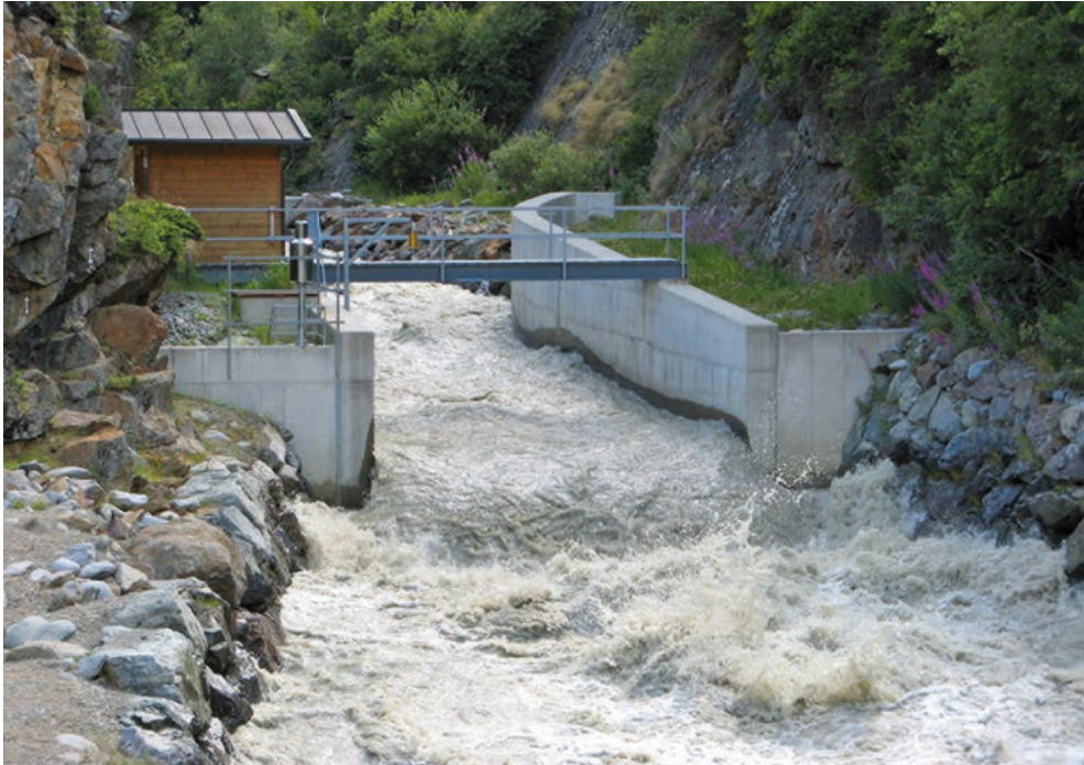
Abb. 4: Die Pegelanlage Vent/Rofenache im Jahre 2005 mit begehbarem Pegelhäuschen, Messsteg und betoniertem Gerinne mit Einlauftrumpete im Oberwasser. Gemessen werden: Wasserstand (RADAR und Drucksonde), Oberflächengeschwindigkeit des Wassers (RADAR), Wassertemperatur, Schwebstoff (Trübungssonde), Geschiebe (Geophone in der Gewässersohle). Sämtliche Parameter werden kontinuierlich gemessen, vor Ort digital aufgezeichnet und mittels GPRS fernübertragen (Foto: Hydrographischer Dienst Tirol)
