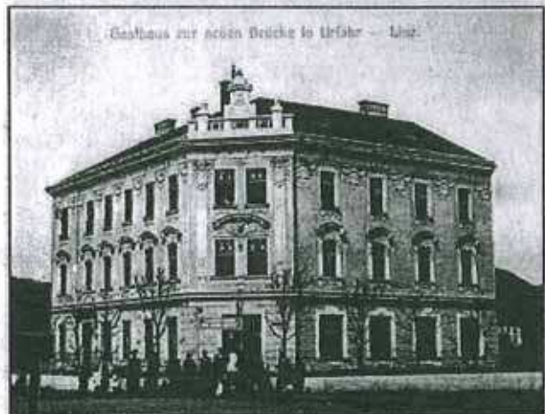
Das Gasthaus Lindbauer kurz nach der vorigen Jahrhundertwende. Das straßenbestimmende Eckhaus verfügt über ein reiches secessionistisches Dekor. Die Gasträume im Inneren sind weitgehend original erhalten. Es bildet seit 100 Jahren einen echten Markstein. FOTOS: ARCHIV DER STADT LINZ
