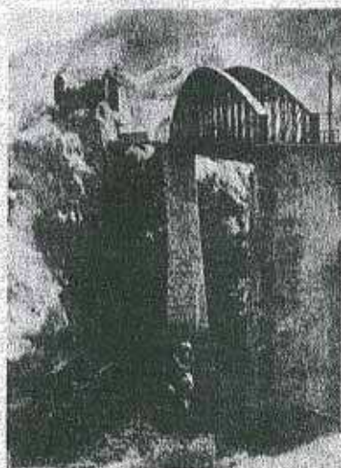
Abb. 6. Trjšanabridge der Uribergbahn, Salzparabelträger, 120 m lang, vor der Verstärkung.
