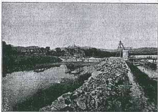
WIDERLAGER, INUNDATIONS- UND TRENNUNGSPFEILER AM LINKEN UFER. (Aufgenommen im Juni 1898.)
