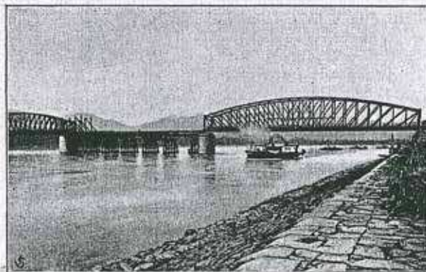
BEGINN DER MONTIERUNG DER MITTLEREN STROMBRÜCKE. (Aufgenommen Ende März 1900.)
