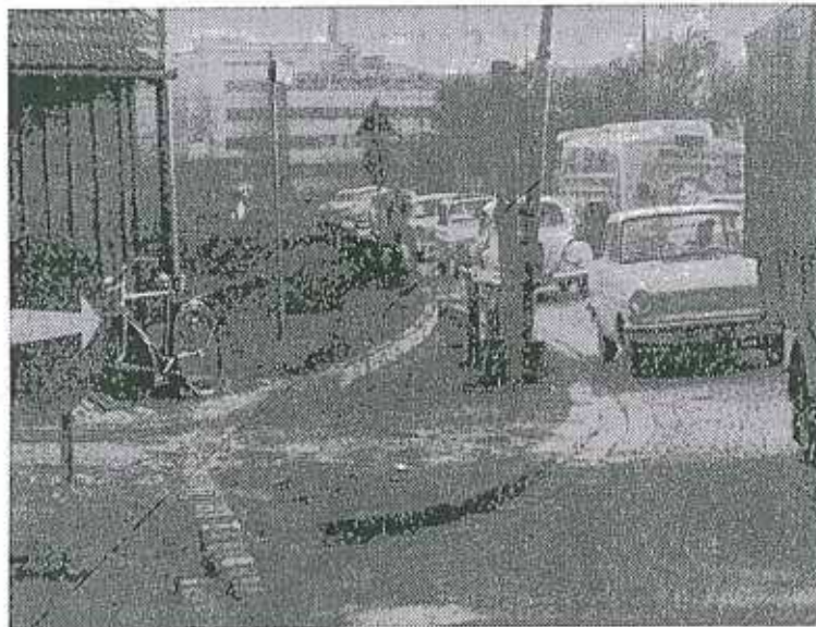
Der gefährliche Engpaß bei der Abfahrt der Eisenbahnbrücke in Linz wird schon in wenigen Tagen aus der Welt geschafft sein. Mit dem Randstein wurde schon deutlich der neue Straßenverlauf markiert. (Kurt Prokosch)
