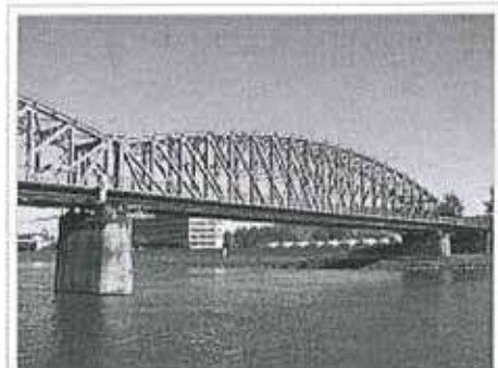
Die Linzer Eisenbahnbrücke, Blick Richtung Osten (flussabwärts)
