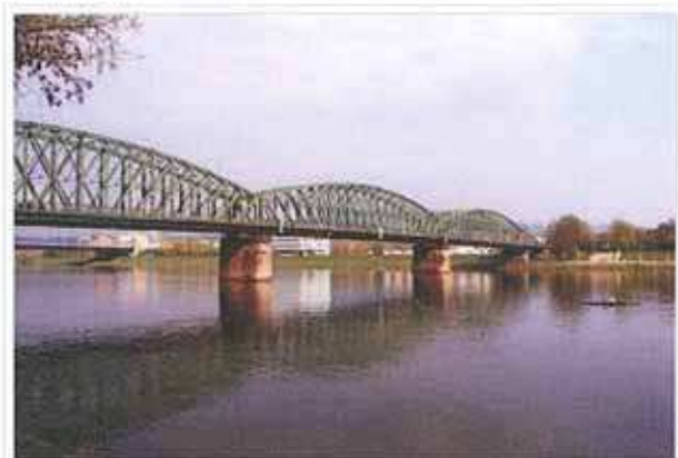
Eisenbahnbrücke bei Tag
