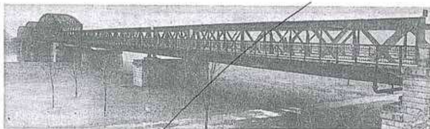
81 JAHRE hat die Eisenbahnbrücke gedient, eine Ideallösung war sie nie. Jetzt soll sie durch einen Neubau mit vier Fahrspuren und getrennten Gleisen ersetzt werden. Foto: ÖÖN/Aigner
