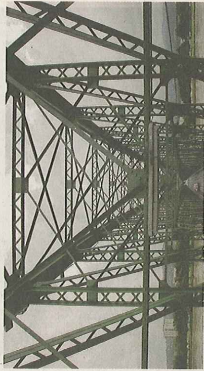
Die Stahlkonstruktion der Brücke ist durch Rost massiv geschädigt. Foto: Weibold
