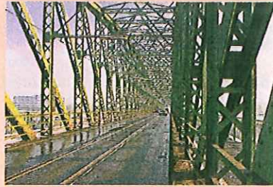
Nadelöhr und Zankapfel zugleich: Die Eisenbahnbrücke Foto: Land OÖ
