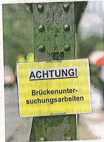
Die Brücke wird untersucht. Foto: vowe
