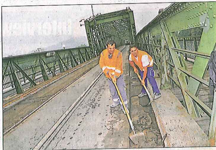
Seit gestern früh werden die Asphaltierungsarbeiten durchgeführt
