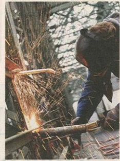
Brücke bis 2015 befahrbar
