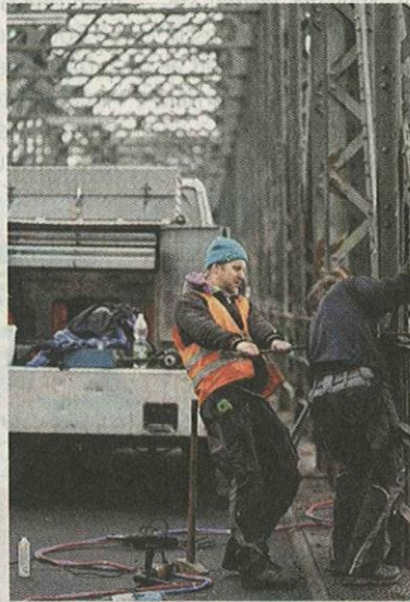
Dauerthema Eisenbahnbrücke (vowe)
