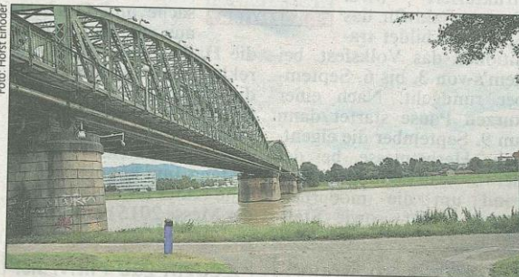
Die alte Linzer Eisenbahnbrücke verbindet die City mit Urfahr
