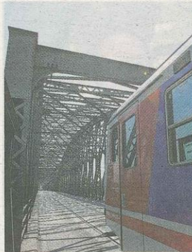
Bald werden keine Züge mehr über die Eisenbahnbrücke fahren. Foto: Weibhold
