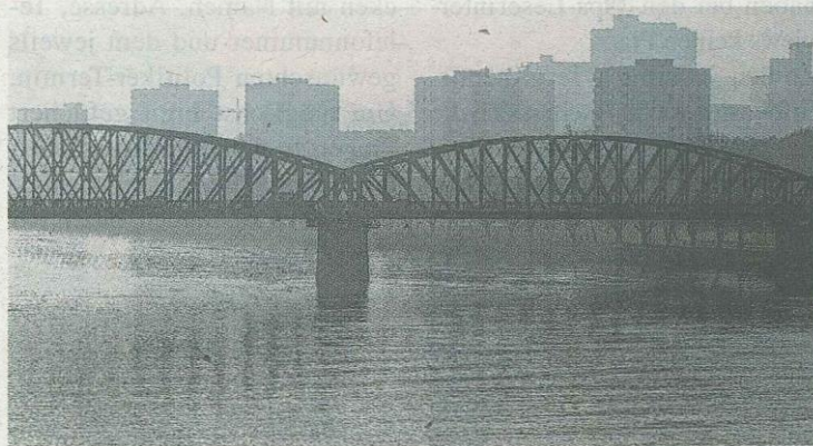
Die Zukunft der Eisenbahnbrücke bleibt noch bis September unklar. Foto: Weihbold
