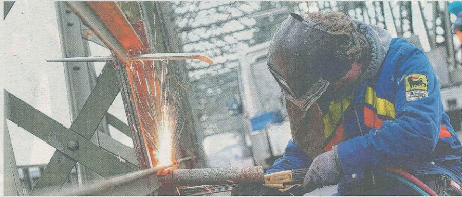
Diesmal sind es Wartungsarbeiten am Tragwerk, die zu einer Sperre der Eisenbahnbrücke führen.
