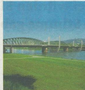
Bleibt die Brücke bestehen, soll sie Fußgängern und Radfahrern vorbehalten sein. Foto: ÖVP Linz
