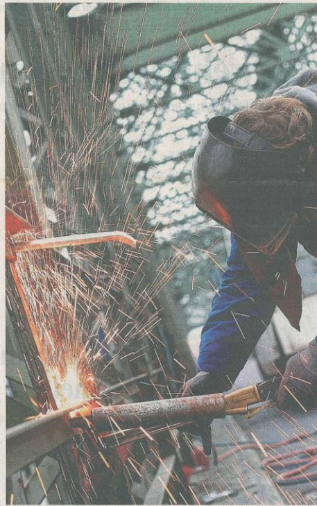
Die 114-jährige Eisenbahnbrücke gilt seit langem als sanierungsbedürftig. (vowe)
