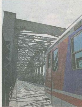
Bald werden keine Züge mehr über die Eisenbahnbrücke fahren. Foto: Weibold
