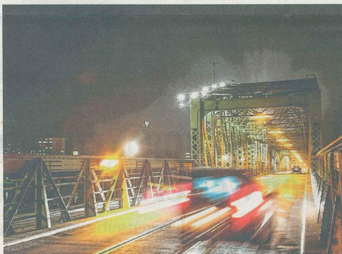
Im Verkehrsausschuss ist morgen die Eisenbahnbrücke erneut ein Thema. (vowe)
