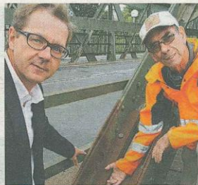
Architekt Jörg Stögmüller (li.) bemängelt den schlechten Zustand der Brücke. Foto: Brücke für Linz
