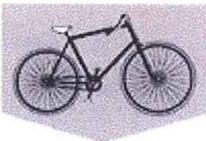
**1888 Luftbereifung** Epochale Verbesserung des Fahrkomforts durch die Luftbereifung (Pneumatik), der Erfindung des schottischen Tierarztes **Dunlop**.
