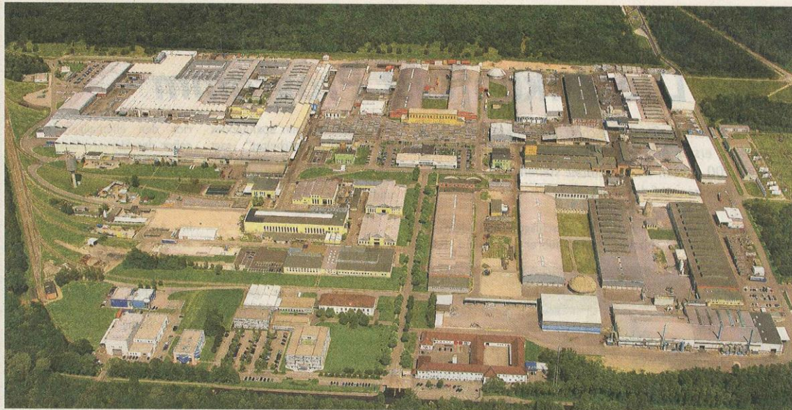
Auf dem Werksgelände der AMAG in Ranshofen wird an vielen Stellen gebaut beziehungsweise modernisiert. Doch nicht nur die Werkseinfahrt und das Verwaltungsgebäude werden neu gestaltet, auch neue Produktionsanlagen befinden sich in Bau. Foto: AMAG
