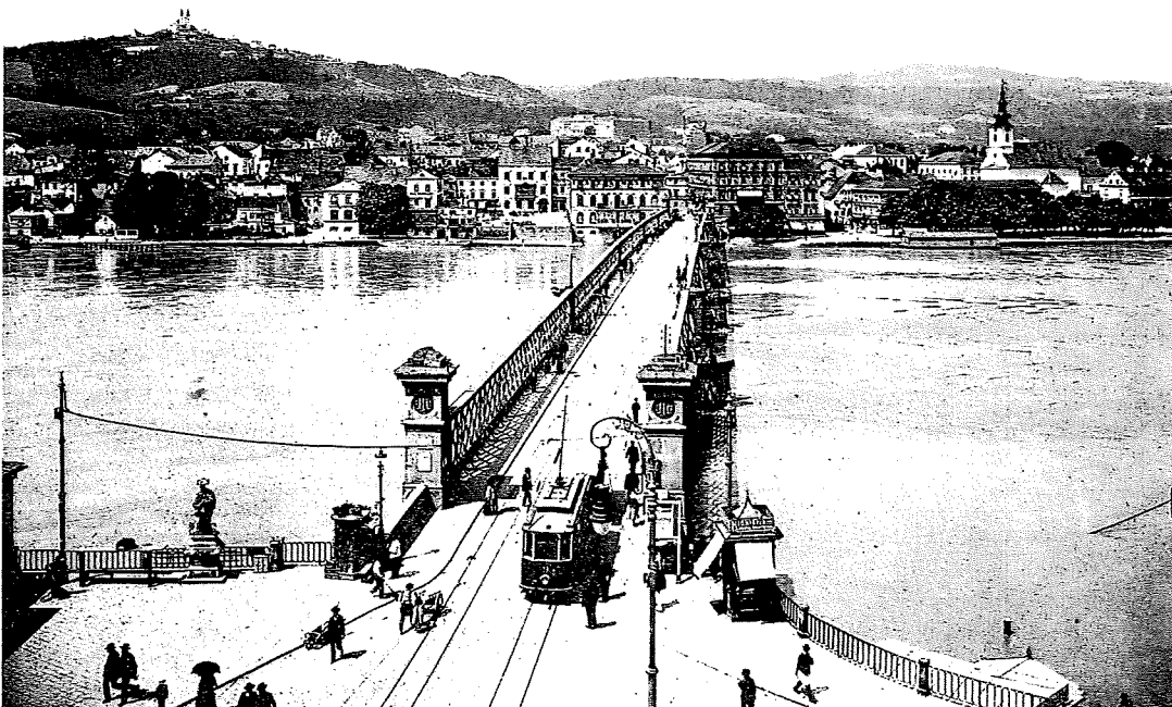
56 Die 1872 eröffnete eiserne Brücke nach Urfahr.
