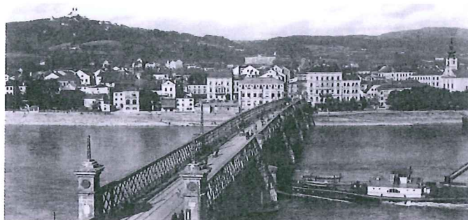
Der Vorgängerbau der Nibelungenbrücke, Blick nach Urfahr
