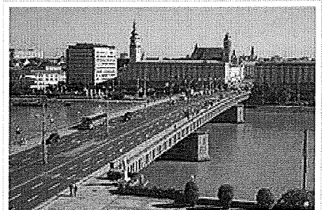
Die heutige Nibelungenbrücke, vom Dach des Neuen Rathauses in Urfahr gesehen.
