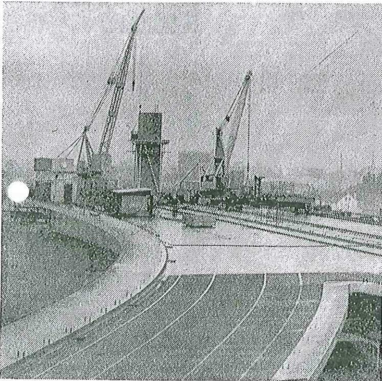
Mit der derzeitigen Höhe von acht Metern nimmt sich der Pylon für die zweite Linzer Donaubrücke noch bescheiden aus. Die Gesamthöhe soll aber 65 Meter betragen, das entspricht etwa der Höhe des Linzer Lenau-Hochhauses.
