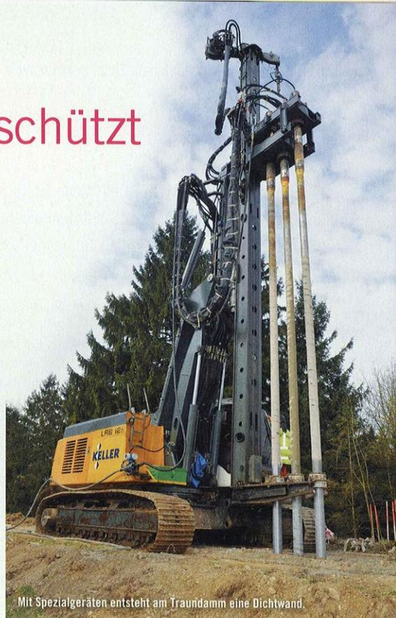
Mit Spezialgeräten entsteht am Traundamm eine Dichtwand.
