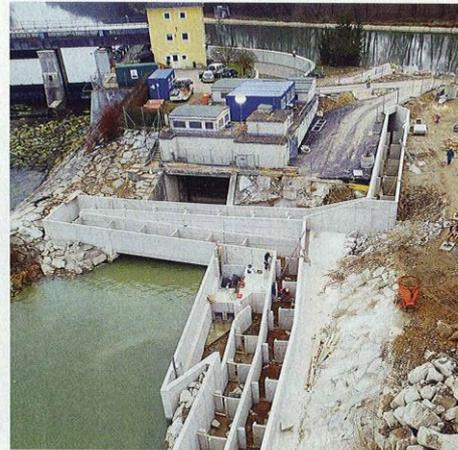
**LINZ STROM GmbH betreibt** zur umweltfreundlichen Energieerzeugung im Süden von Linz einerseits das Wasserkraftwerk Kleinmünchen und andererseits eine Turbine beim nahe gelegenen Traunwehr. Bei einem Sanierungsprogramm wurde eine Aufstiegshilfe errichtet, um die Fischpassierbarkeit herzustellen. Damit wird die LINZ STROM GmbH auch der EU-Wasserrahmenrichtlinie gerecht.
