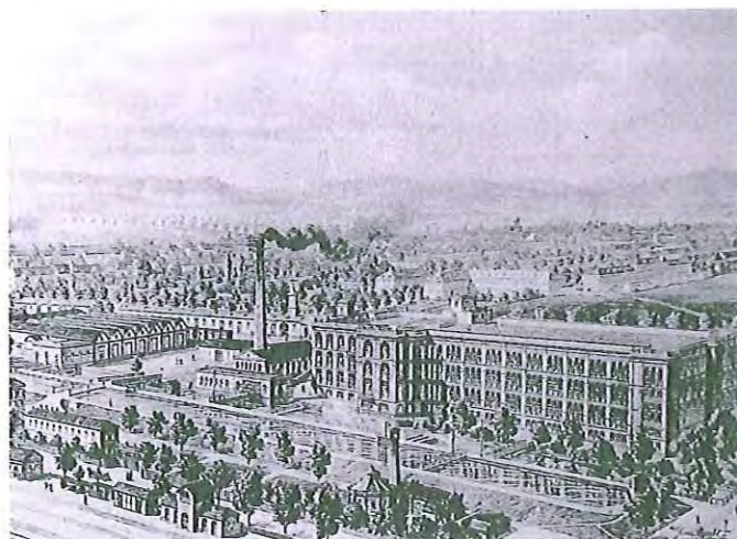
Das Fabriksareal der Pottendorfer Garnmanufakturgesellschaft; im Hintergrund in symmetrischer Anordnung Beamten- und Kinderhaus, im Vordergrund das vierstöckige Produktionsgebäude mit dem Maschinenhaus und niedrige Schedhallen (ganz links), Lithographie, um 1898
