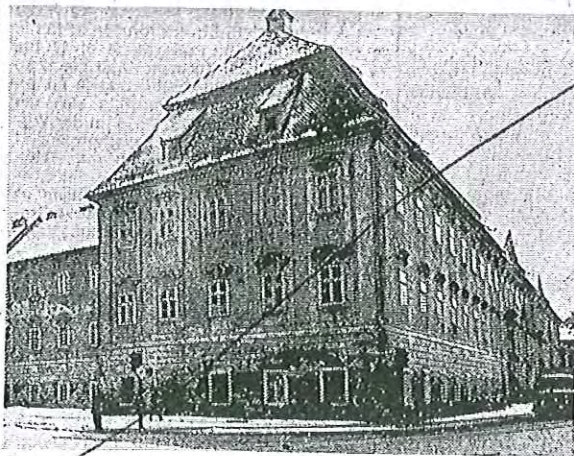
STIEFMÜTTERLICH BEHANDELT , wie die abgerissene Wollzeugfabrik (Bild), werden auch in Oberösterreich die Industriebaudenkmäler, denen „Unterwegs in Österreich“ eine Sendung widmet.
