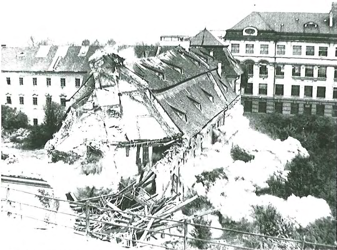
Das gewaltige Mansarddach der Linzer Wollzeugfabrik während der Sprengung 1969.
