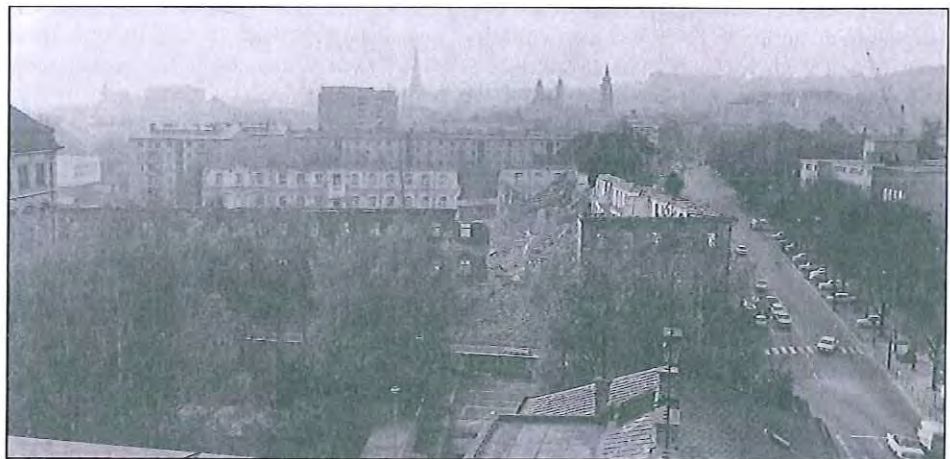
Der Abbruch des Hauptgebäudes der Wollzeugmanufaktur im November/Dezember 1969 ASTL, Fotosammlung
