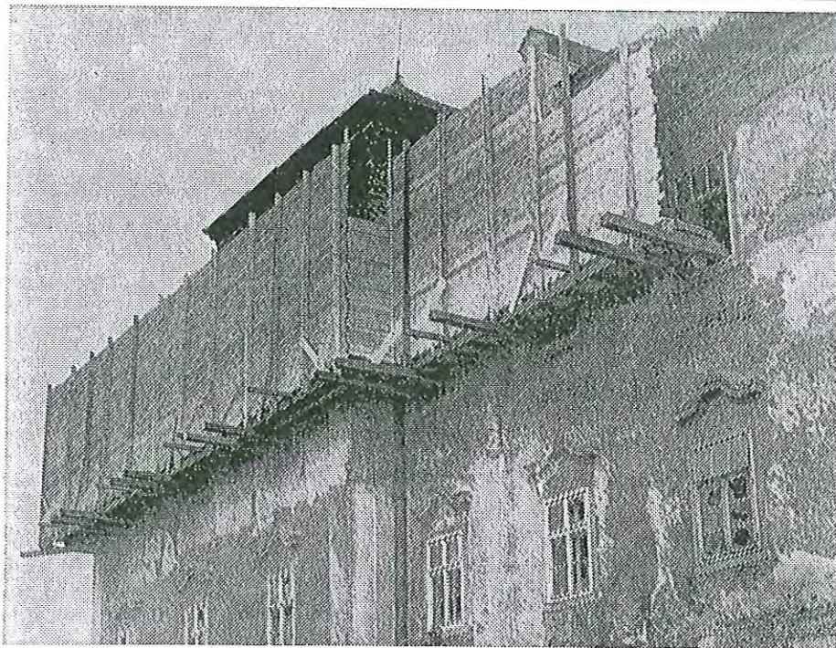
An der Gebäudefront der Wollzeugfabrik in der Gruberstraße wurde dieser Tage ein Ausschußgerüst mit starker Fangblende eingebaut, womit die Austria-Tabakwerke als Eigentümer des Gebäudes erste Sicherungsmaßnahmen zum Schutz der Fußgeher getroffen haben, die bei Sturm, starkem Temperaturwechsel oder Schneedruck durch das bröckelige und verwitterte Mauerwerk gefährdet sind. Nächste Woche wird über einen Antrag der Austria-Tabakwerke, ein großes Portalgerüst mit Fangblende aufzustellen, die kommissionelle Verhandlung durch die Bezirksverwaltungsbehörde abgeführt werden. Es ist vorgesehen, das Portalgerüst so aufzustellen, daß Fußgeher den Gehsteig passieren können.
