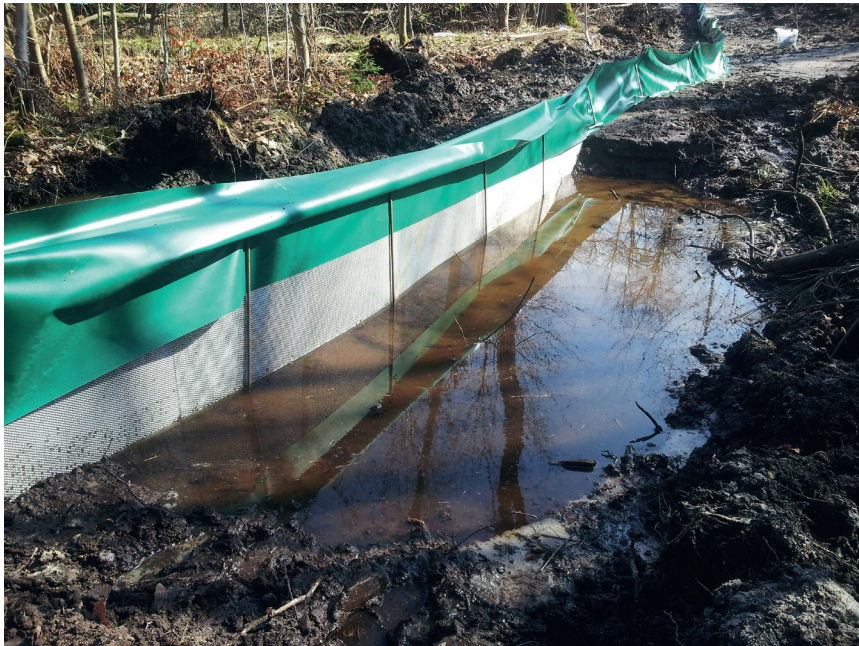
Abb. 4: Zur molchsicheren Abdichtung eingebaute Streckmetallgitter im Bereich des Wasserteinslaufes zu Altgewässer 3 (Foto: Bruno Scheel).
