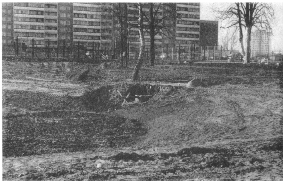
Abb. 2 Der „Flohsteich“ zum Zeitpunkt der Tiefbauarbeiten
