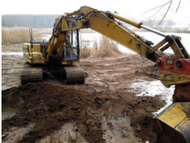
Abb. 2: Mittels Kettenbagger wurde das Aushubmaterial als Flachwasserzone gestaltet Foto: J. Marabini, 16.1.2012
