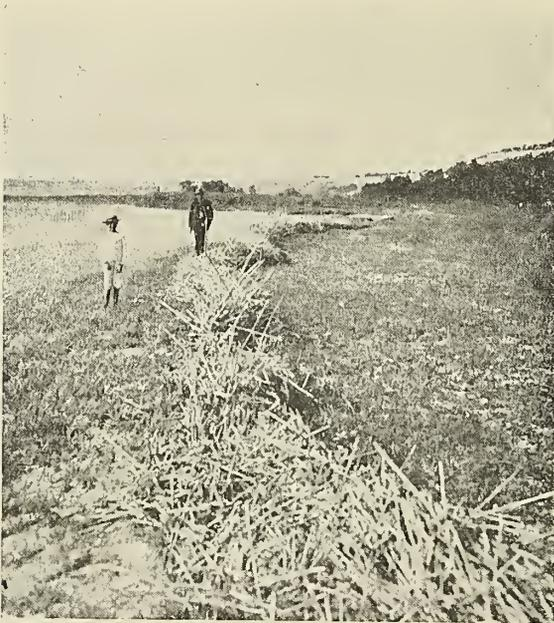
Fig. 128 Aus Rohr aufgebaute Nehrung bei Balaton-Világos, dem maximalen Wasserstande entsprechend.
