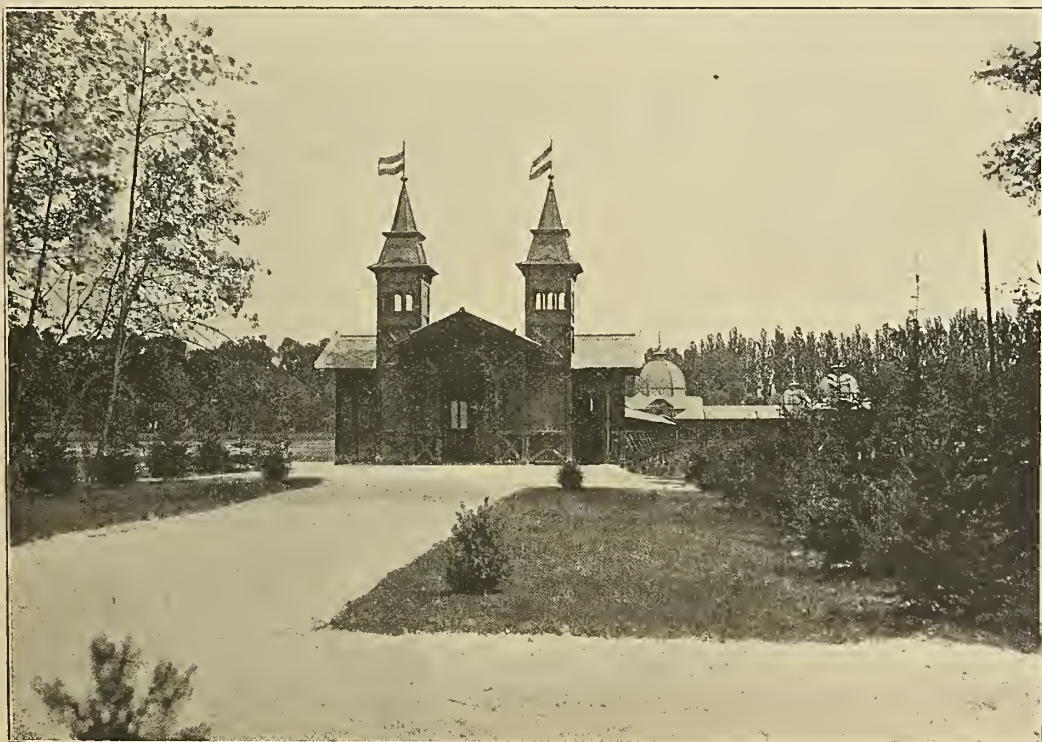
Fig. 10. Der westliche Haupteingang des im Frühjahr 1906 fertiggestellten Badchauses. Im Vordergrund das Billethaus. An der rechten Seite der gedeckten Eingangsbrücke sind noch einige Piloten der 1860 geschlagenen Brücke sichtbar, welche man nicht herausziehen konnte. Nach einer 1906 durch EUGEN KNEBEL bewerkstelligten photographischen Aufnahme.
