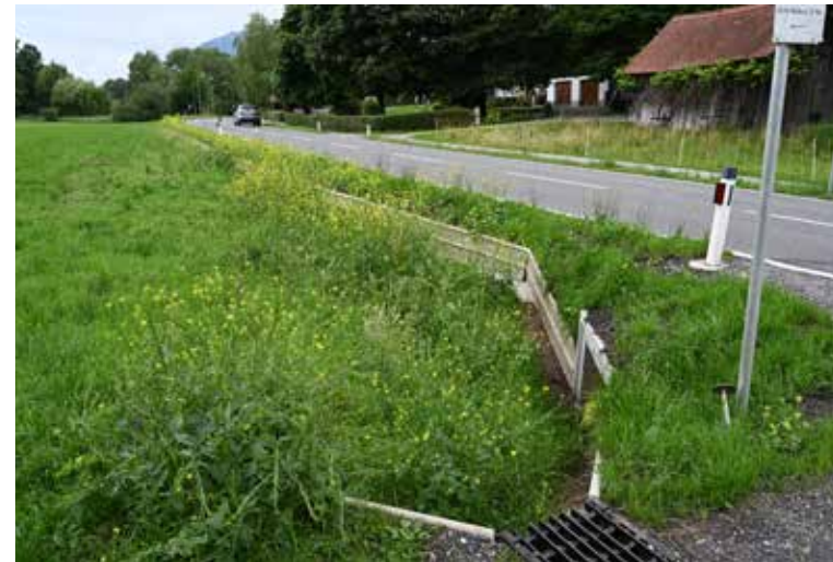
Abb. 113: Österreichweit sind über 1.000 Amphibienwanderstrecken an Straßen bekannt. Weniger als ein Zehntel wurden durch permanente Schutzanlagen gesichert, die ein gefahrloses Unterqueren der Straße ermöglichen (KYEK et al. 2016). An der L59 in Koblach wurde mit großem Aufwand eine Querungsmöglichkeit installiert (Foto: UMG).
