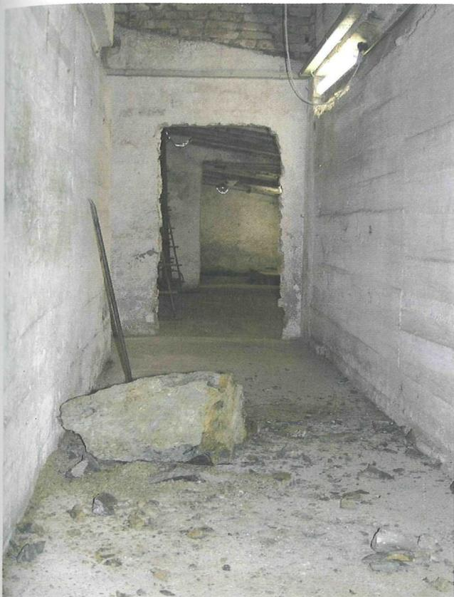
Abb. 6: Lockere Felsblöcke an der Decke des Luftschutztollens weisen mitunter eine beträchtliche Größe auf und müssen unbedingt entfernt werden; Aufn. R. K. Eberwein
