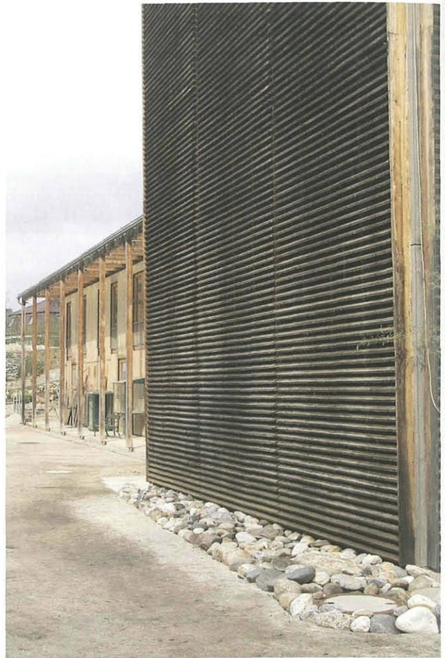
Abb. 2: Neu angelegter Spritzwasserschutz aus grobem Flussschotter vor dem Archivturm. Aufn. R. K. Eberwein
