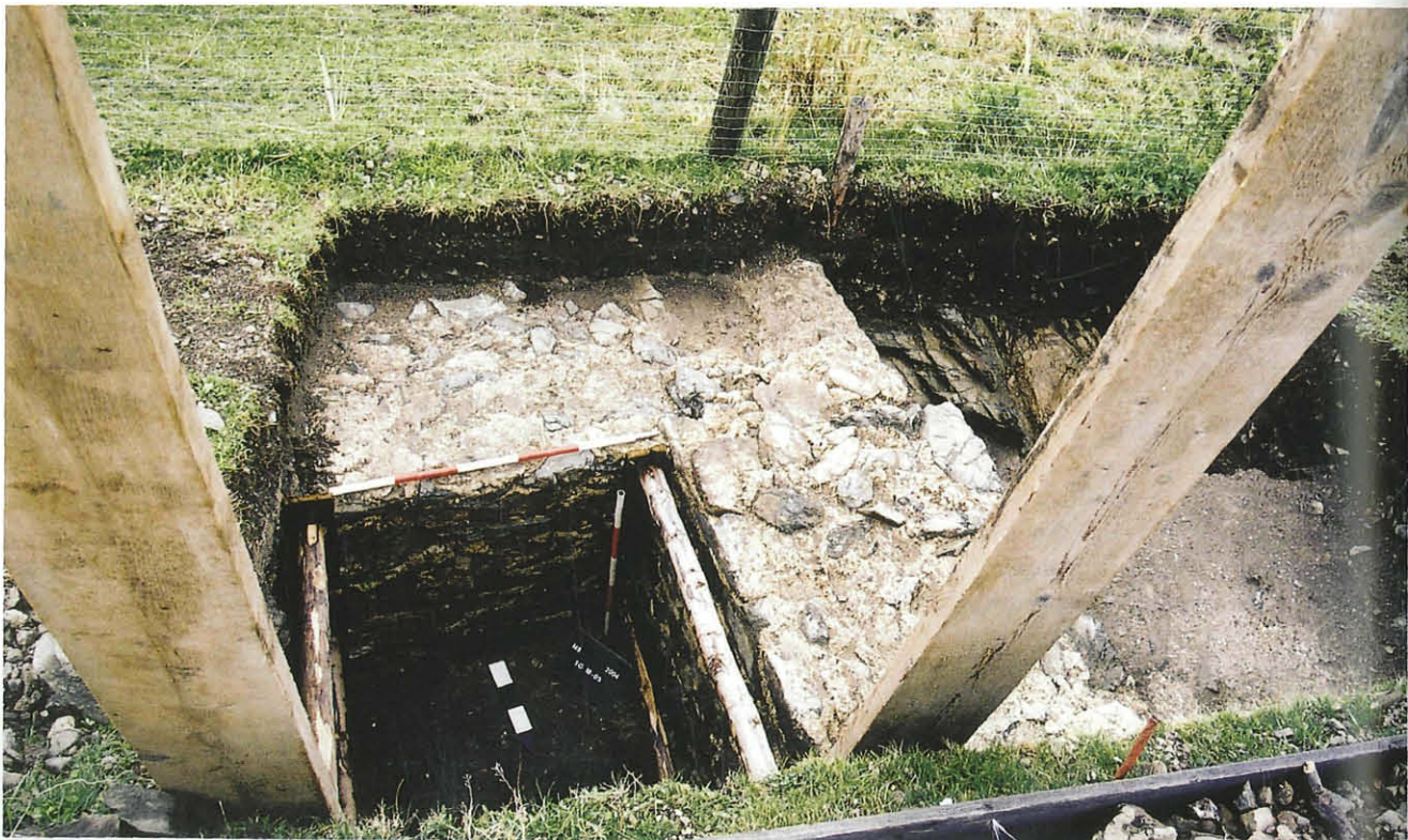
Abb. 3: Befestigungsmauer M 1 in SG 9/04. Blick aus Osten. Aufn. I. Dörfler
