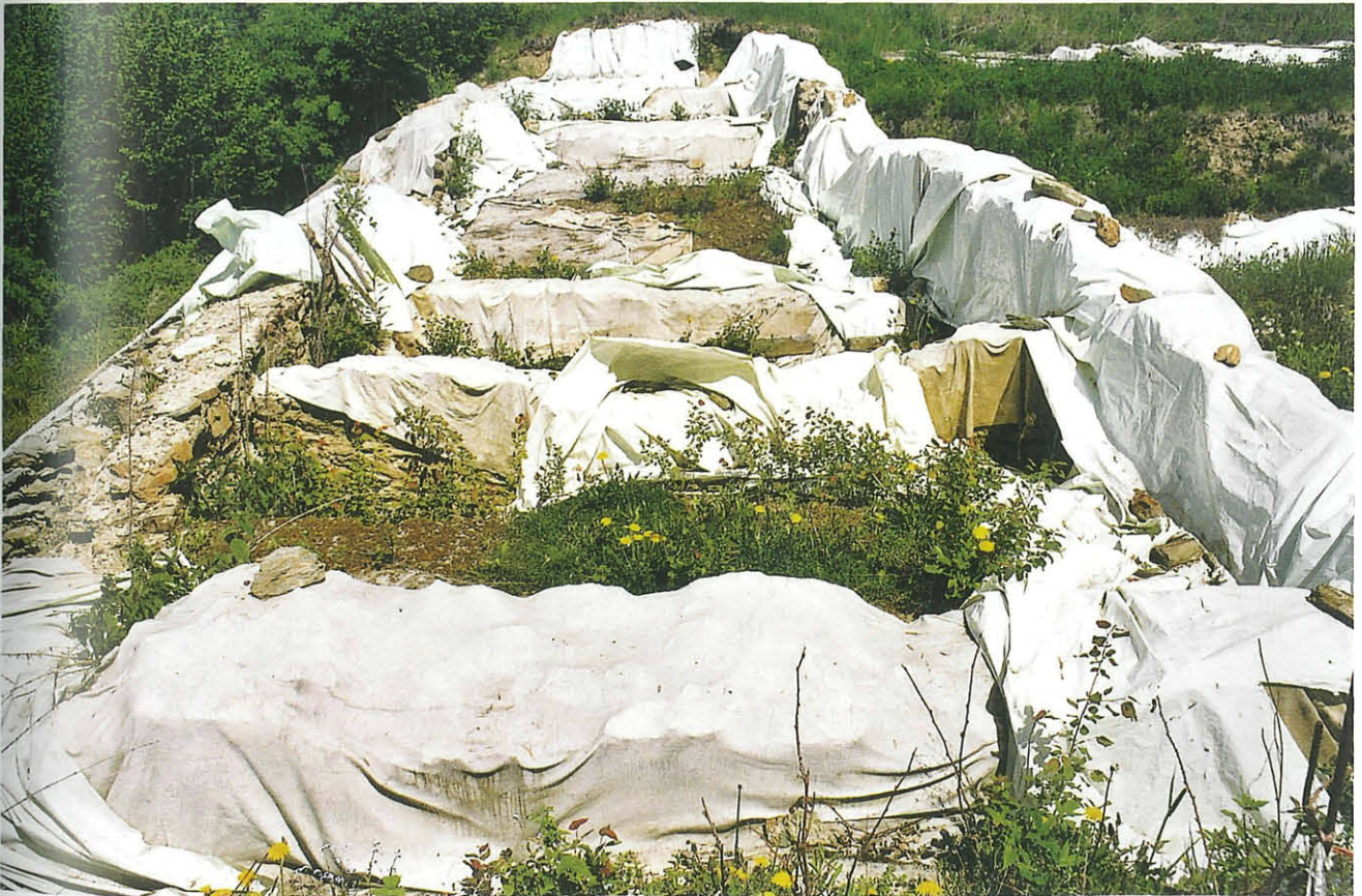
Abb. 1: West-Cavea. Abdeckung 2001 mit Planen und unterliegenden Bauvliesen. Blick aus Süden. Aufn. R. Barlovits
