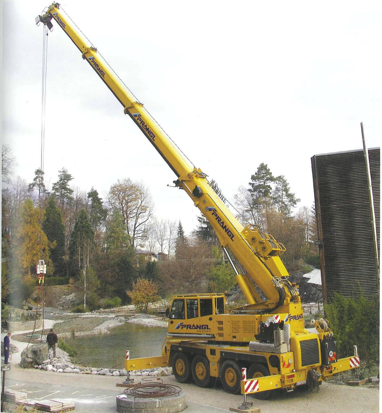
Abb. 2: Versetzen eines 6 t schweren Grünschiefer-Blocks mit Hilfe eines Spezialkrans. Aufn. R. K. Eberwein
