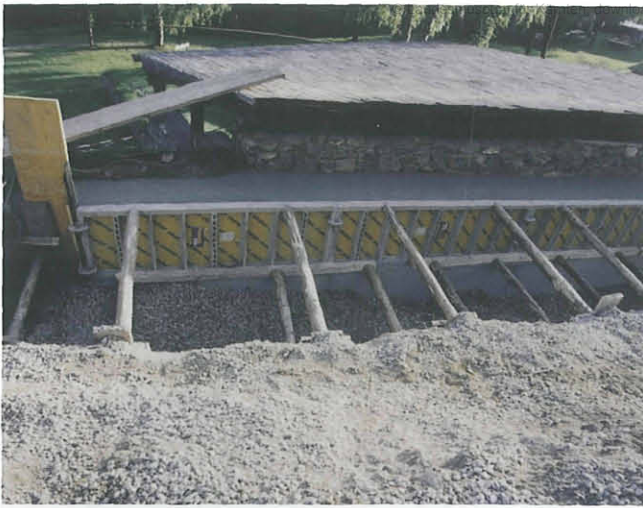
Abb. 9: Zweiter Abschnitt und Hinterfüllung der Schwergewichtsmauer an die Nordmauer von NG/33. Blick aus Norden. Aufn. J. Polleres
