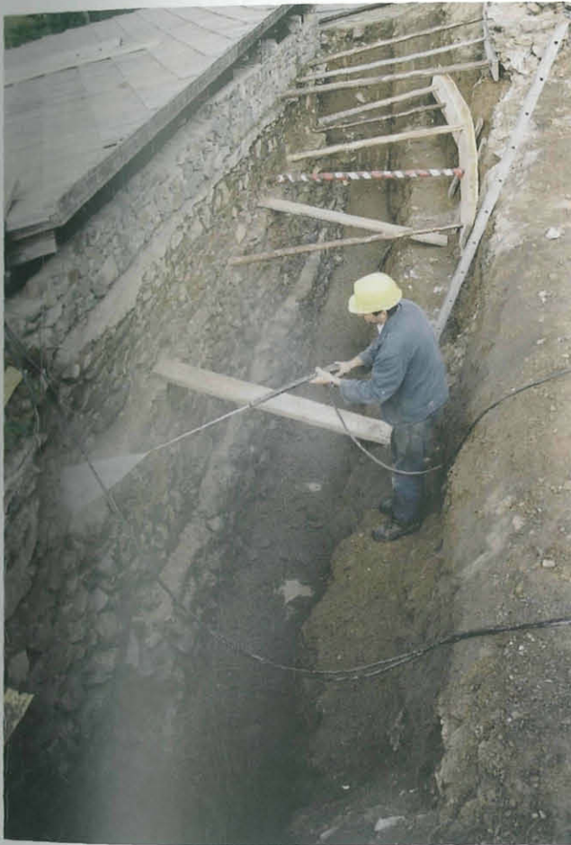
Abb. 7: Nordmauer von NG/33. Reinigung mit Hochdruck. Blick aus Nordosten. Aufn. H. Dolenz
