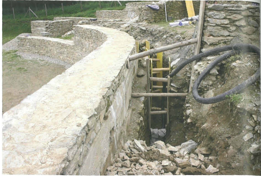
Abb. 4: Ost-Cavea. Drainagierung und Sammelschacht im Ringkanal zwischen den beiden inneren Caveamauern M 1 und M 2 im Bereich der Nordost-Kurve. Blick aus Süden. Aufn. R. Barlovits
