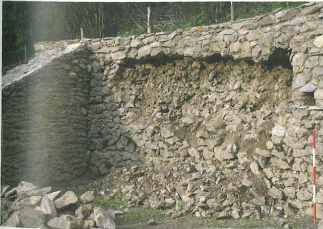
Abb. 1: Amphitheater Virunum. Nordost-Kurve. Mauerausbruch in der äußeren Caveamauer M 3. Blick aus Südwesten. Aufn. R. Barlovits
