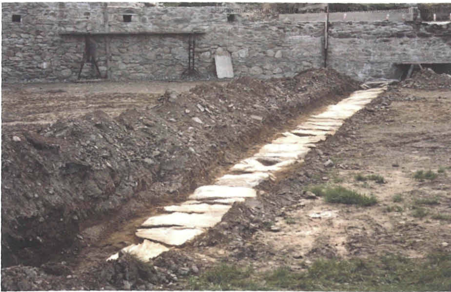
Abb. 7: Nördliche Arena. Kanal 1 Ost. Blick nach Osten. Aufn. R. Barlovits
