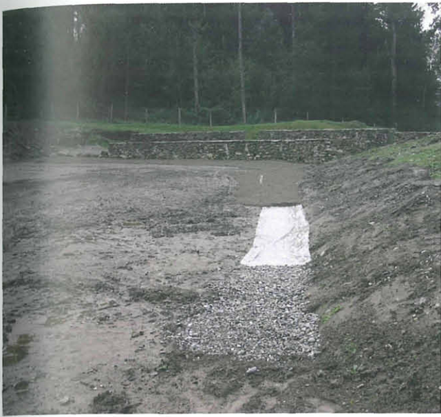
Abb. 6: Die Oberflächendrainage in der südlichen Arena. Blick aus Norden. Drainage entlang der M 1 der West-Cavea. Aufn. R. Barlovits
