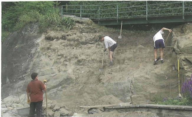
Abb. 6: Nach Entfernung der schlecht gesicherten Felsblöcke mussten aus der Felswand einige Tonnen Erdmaterial verfrachtet werden. Aufn. R. K. Eberwein
