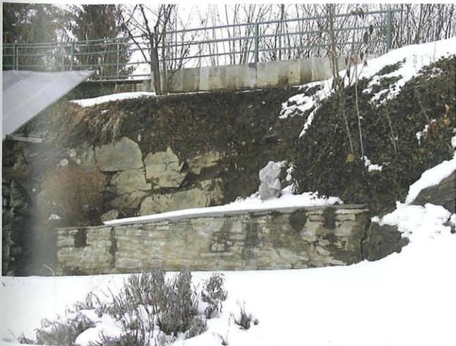
Abb. 4: Massive Schäden an der Trockensteinmauer unterhalb des mit einem Geländer gesicherten Weges. Große Erdbereiche liegen bereits frei, die herausgefallenen Steine wurden bereits entfernt. Der darüberliegende Weg ist gefährdet. Aufn. R. K. Eberwein
