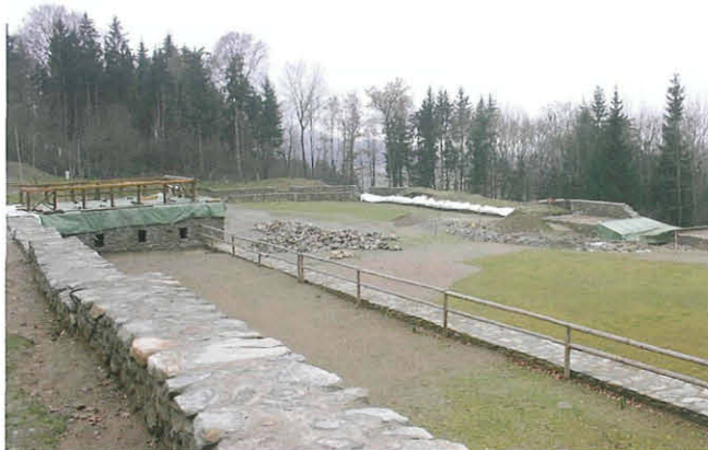
Abb. 2: Amphitheater von Virunum. Restaurierungsbestand November 2006. Gesamtansicht des östlichen und westlichen Zuschauerraumes. Nemesisheiligtum unter Schutzabdeckung. Blick aus Nordosten. Aufn. R. Barlovits
