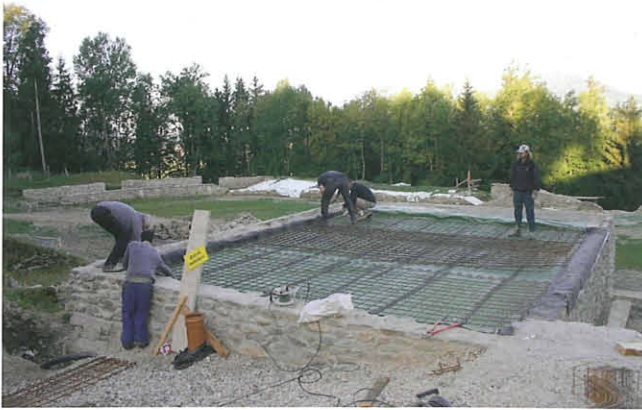
Abb. 6: Nemesisheiligtum. Verlegen der Baustahlgittermatten zur Armierung der Flachbetondecke. Blick aus Osten. Aufn. R. Barlovits
