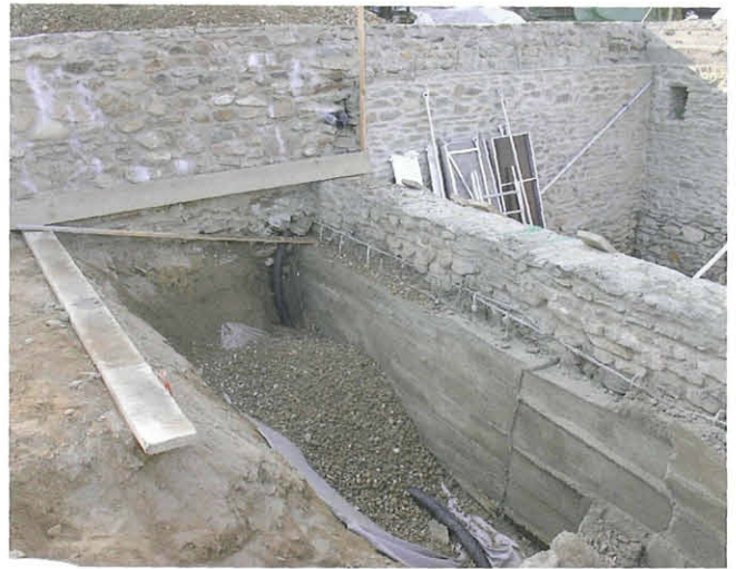
Abb. 7: Nemesisheiligtum. Nördliche Seitenwand R 19, Drainagierung. Blick aus Norden. Aufn. R. Barlovits
