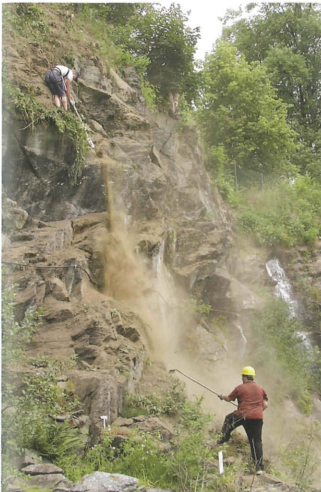
Abb. 5: Die Sicherung und Sanierung der Felswände ist eine besondere Herausforderung für die Mitarbeiter des Botanischen Gartens. Stephan Katzenberger befreit – am Seil hängend und von Johann Bostjancic unterstützt – Teile der Felswand von großen Mengen an lockeren Steinen und Erdmaterial. Aufn. R. K. Eberwein, LMK-KBZ
