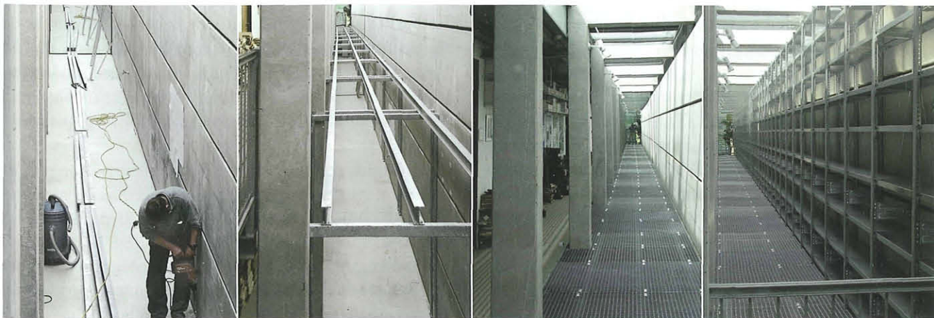
Abb. 3: Im Erdgeschoß der Pflanzenhalle gesetzte Bodenanker (links) tragen ein Stahlgerüst zur Aufnahme von Doppel-T-Trägern (Mitte links). Nach Entfernung des Geländers und Verlegung eines Gitterbodens (Mitte rechts) erfolgte der Aufbau des 20 m langen Bibliotheksregals (rechts). Aufn. R. K. Eberwein, LMK-KBZ
