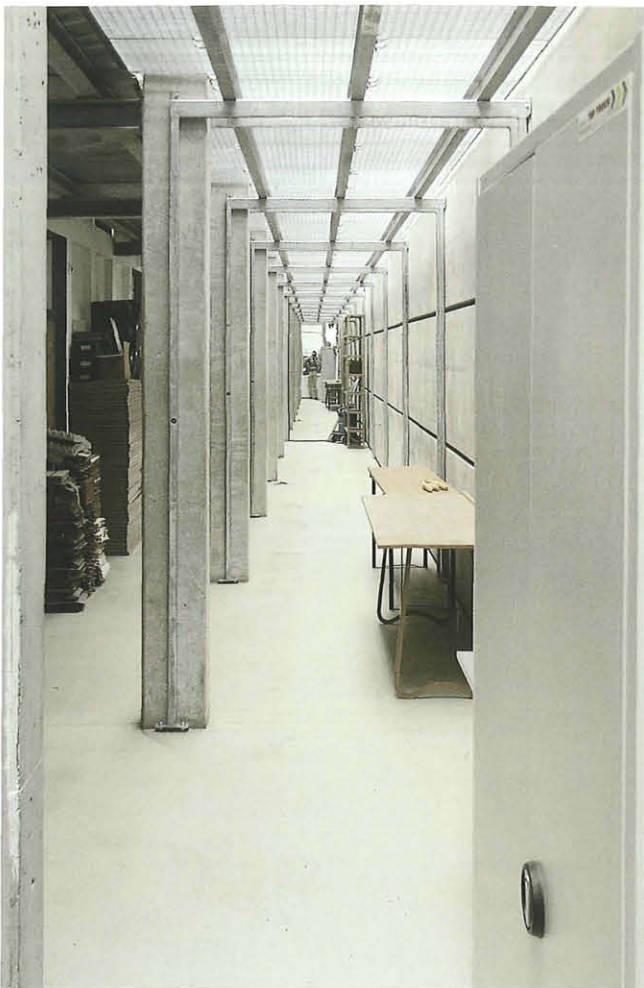
Abb. 4: Erdgeschoss nach dem Einbau des Gitterbodens. Aufn. R. K. Eberwein, LMK-KBZ
