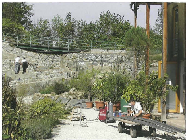
Abb. 8: GM Gerald Dürr, Stephan Katzenberger und Elias Molitschnig vermessen Felsbereich und Nirosta-Rohre für die Anfertigung eines temporären Daches für das neue Freilandkakteen-Quartier. Sämtliche Schweißarbeiten werden in Eigenregie ausgeführt. Aufn. R. K. Eberwein, LMK-KBZ
