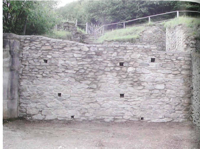
Abb. 4: Westmauer G nach Fertigstellung. Aufn. H. Dolenz
