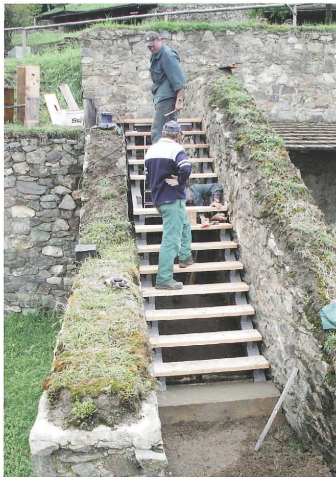
Abb. 6: Treppe in SH/6b. Aufn. W. Jandl
