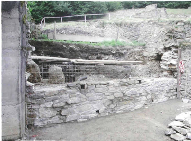
Abb. 3: Neubau der Westmauer G. Aufn. H. Dolenz
