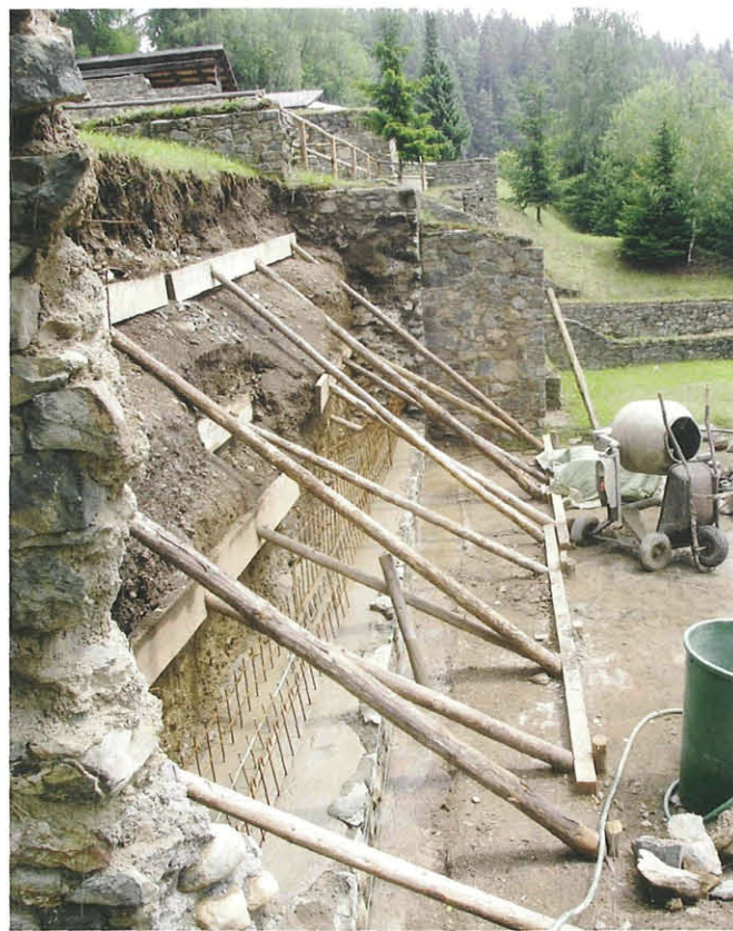
Abb. 2: Wiederaufbau der Südmauer SH/4. Aufn. H. Dolenz
