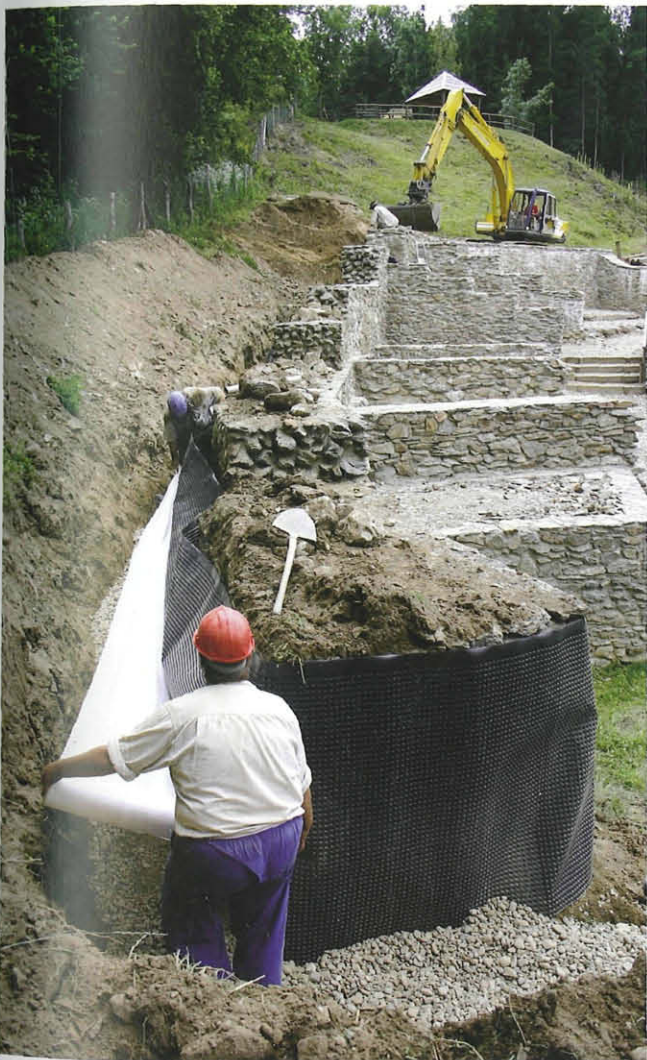
Abb. 7: Ost-Cavea. Tiefdrainagierung der äußeren Mauer M 3 des nordöstlichen bzw. östlichen Zuschauerraums. Blick aus Westen. Aufn. R. Barlovits
