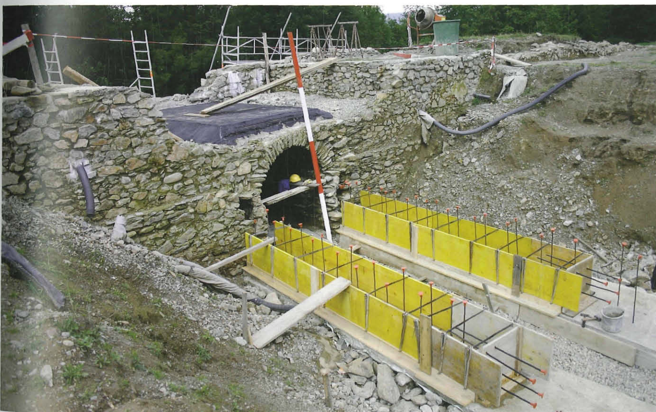
Abb. 5: West-Cavea. Stahlbetondecke über dem Gewölbe des Gladiatorenganges. Im Vordergrund Schalung der Seitenwände zur Rekonstruktion des unterirdischen Ganges. Blick aus Südosten. Aufn. R. Barlovits
