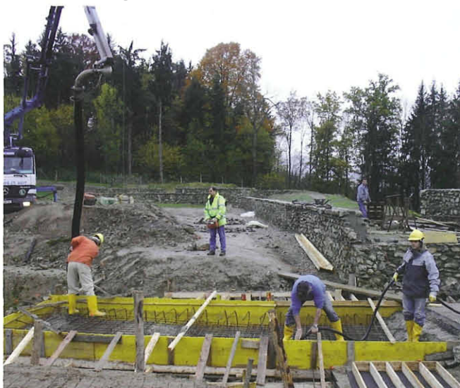
Abb. 6: West-Cavea. Aufbringen der Gussbetondecke auf den unterirdischen Gladiatorengang. Blick aus Norden. Aufn. R. Barlovits
