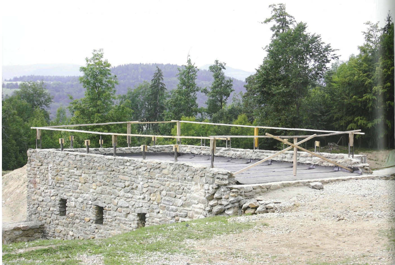
Abb. 9: Ost-Cavea, Nemesisheiligtum mit darüber aufgebrachter Deckenisolierung. Blick aus Südosten. Aufn. R. Barlovits
