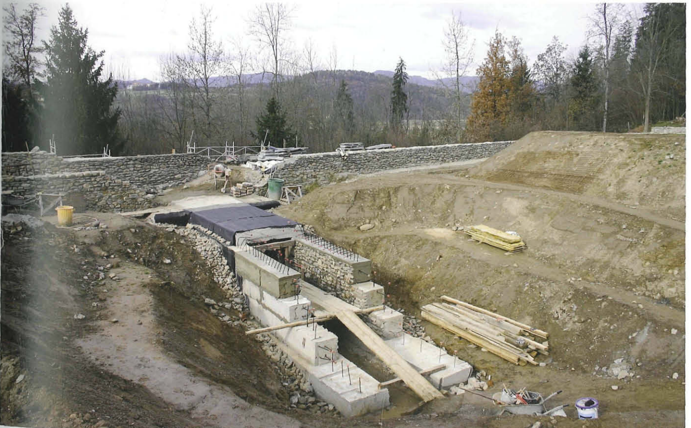
Abb. 2.: West-Cavea. Teilrekonstruktion des unterirdischen Gladiatorenengangs in die Arena. Blick aus Südosten. Aufn. R. Barlovits
