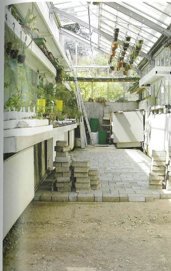
Abb. 12: Statt eines Erdbodens erhält das Glashaus einen pflegeleichten Boden aus Betonsteinen. Aufn. R. K. Eberwein
