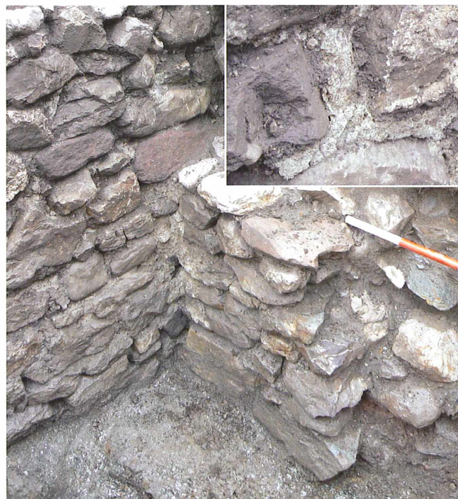
Abb. 8: Gurina. Südseitige römische Befestigungsmauer. Grabung 2008. Aufn. P. Gamper
