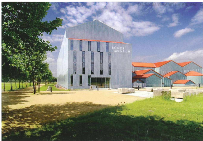
Abb. 7: Xanten, Kr. Wesel (Deutschland), Römermuseum und Schutzbau über den Thermen (2008). Aufn. Archäologischer Park Xanten
