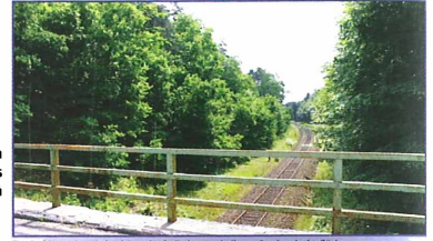
Peratschitz. Das Bahngleis verläuft direkt unterhalb von Fundverdachtsflächen
