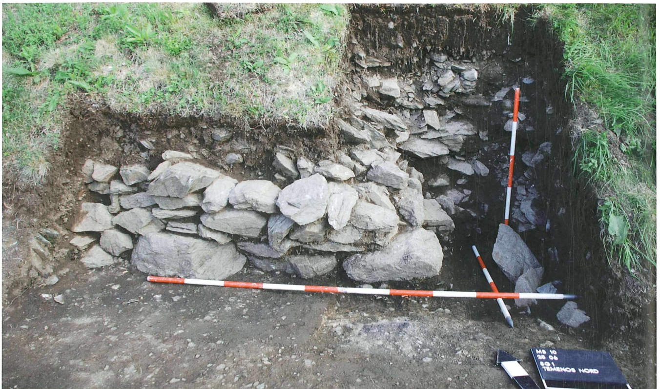
Abb. 5: Überblick Hangbefestigungsmauer und Schnitt 86/57 im Osten. Aufn. D. Ebner
