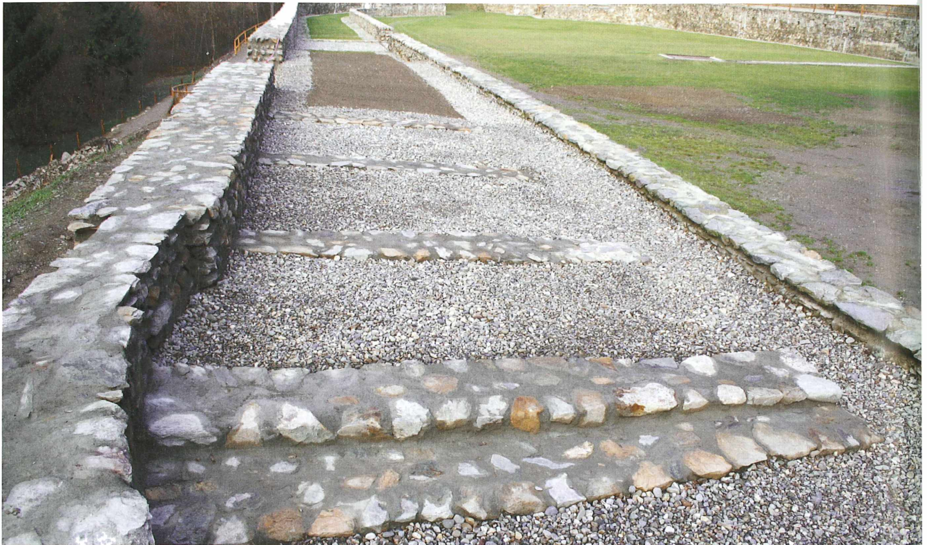
Abb. 4: West-Cavea. Gesamtansicht der wiederhergestellten Teile der äußeren Caveamauer M 3 sowie der konservierten Radialmauern des südlichen Teils des Zuschauerraums. Im Vordergrund die Radialmauern R VIII a und b. Blick aus Süden. Aufn. R. Barlovits
