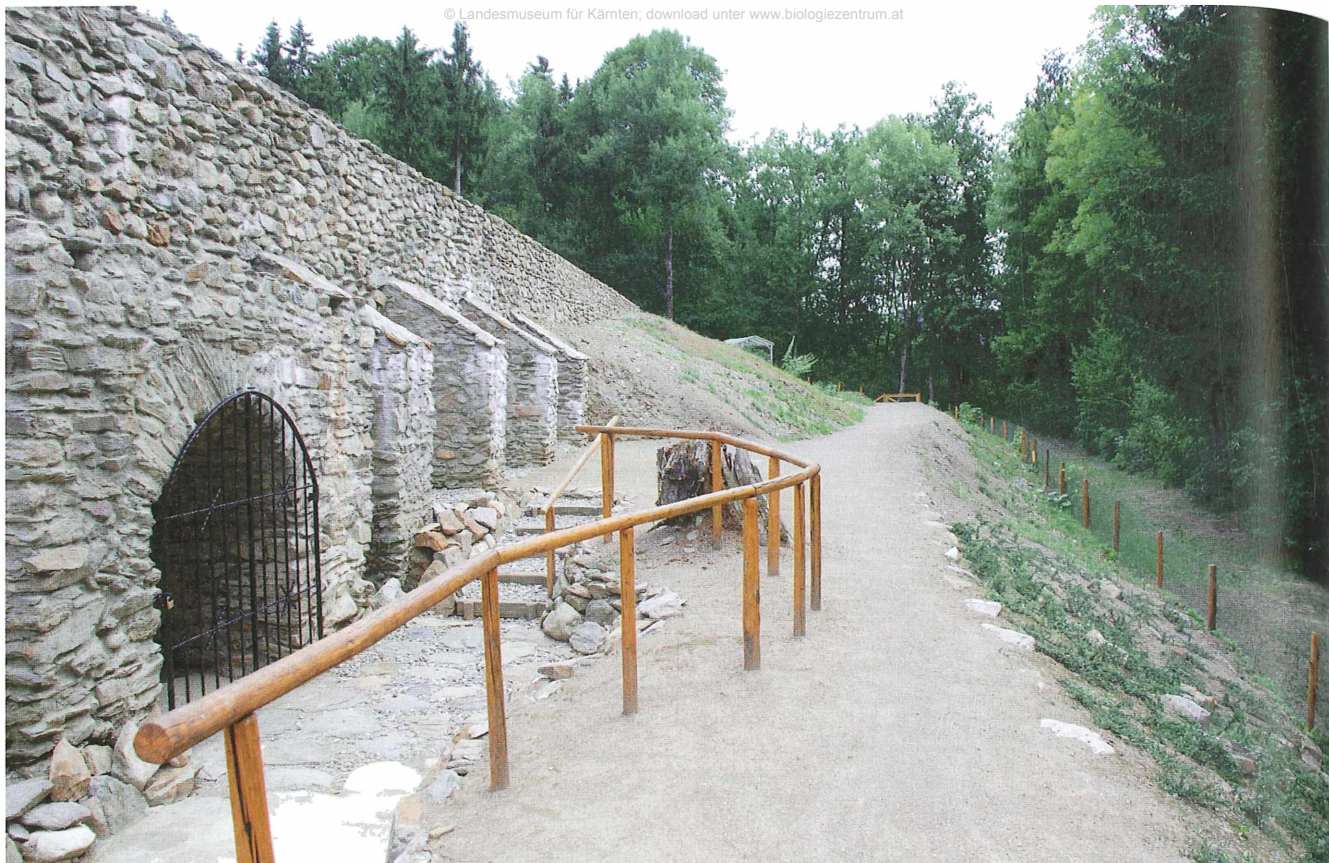
Abb. 17: West-Cavea. Der neu gestaltete Eingangsbereich zum unterirdischen Gladiatorengang in die Arena. Blick aus Norden. Aufn. R. Barlovits.
