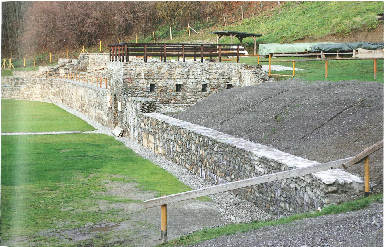
Abb. 5: Ost-Cavea. Gesamtansicht der modellhaft rekonstruierten inneren Caveamauer M 1 des südlichen Teils des Zuschauerraums. Blick aus Südwesten. Aufn. R. Barloviits.
