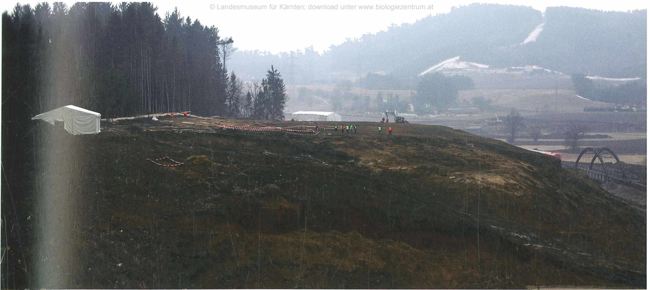
Abb. 2: ÖBB-Großbaustelle Baulos 1 Lavanttal. Voruntersuchung der Hochterrasse über der Lavant. Aufn. R. Barlovits
