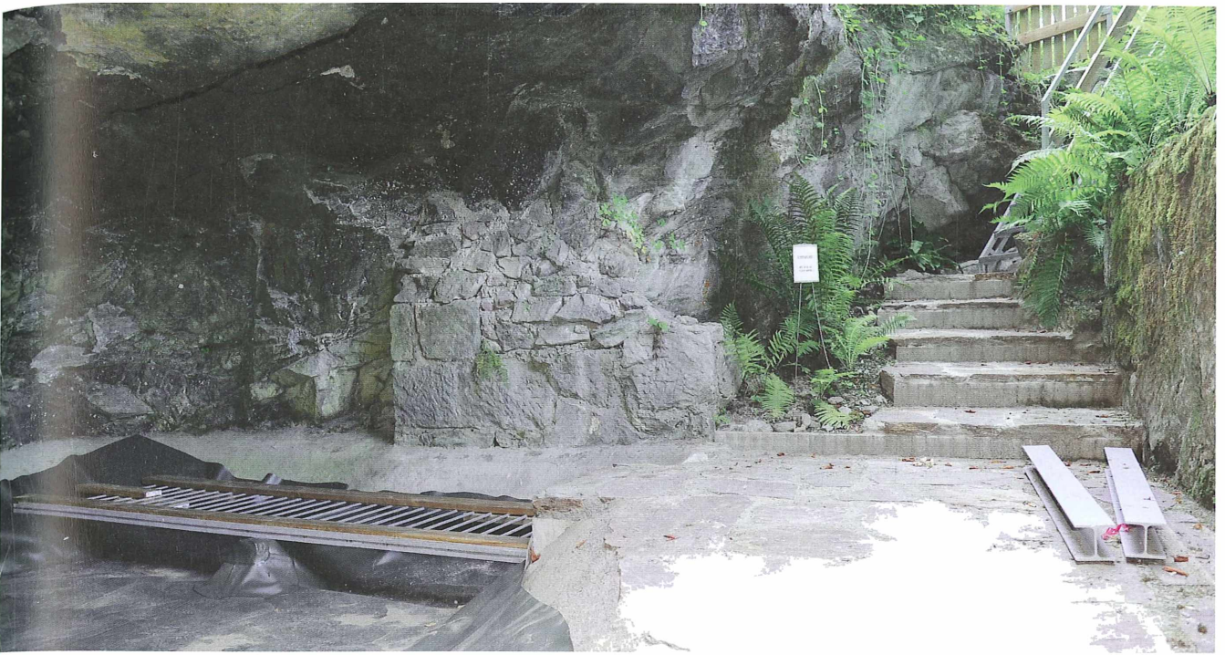
Abb. 9: Sanierung des Stolleneingangs der „Farnschlucht“ und Erneuerung der Wege. Aufn. R. K. Eberwein, LMK-KBZ
