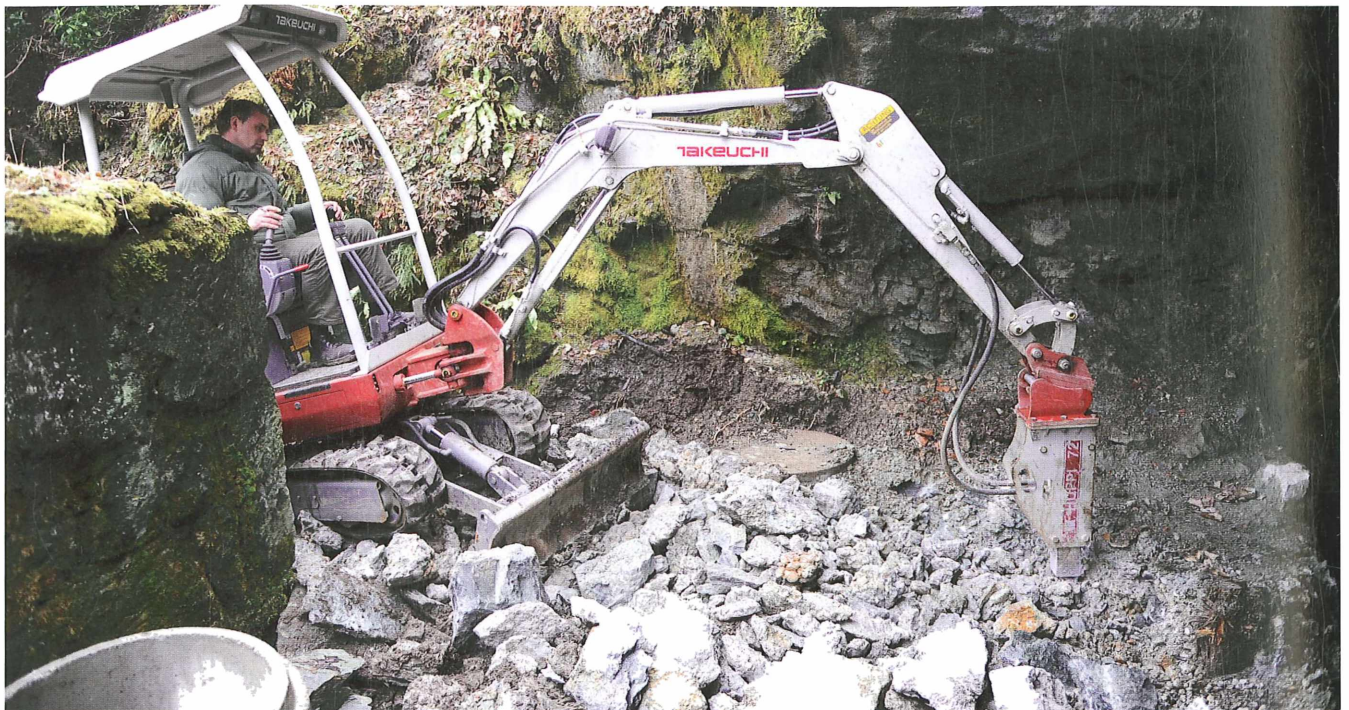
Abb. 8: Entfernung des 2 m dicken Beton-Splitterschutzes aus dem II. Weltkrieg aus der „Farnschlucht“ des Botanischen Gartens. Aufn. R. K. Eberwein, LMK-KBZ
