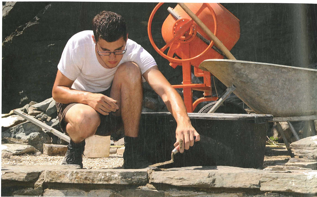
Abb. 21: Eine zerfallende Steinmauer wird durch unseren Ferialpraktikanten Simon Dürr saniert. Aufn. R. K. Eberwein, LMK-KBZ
