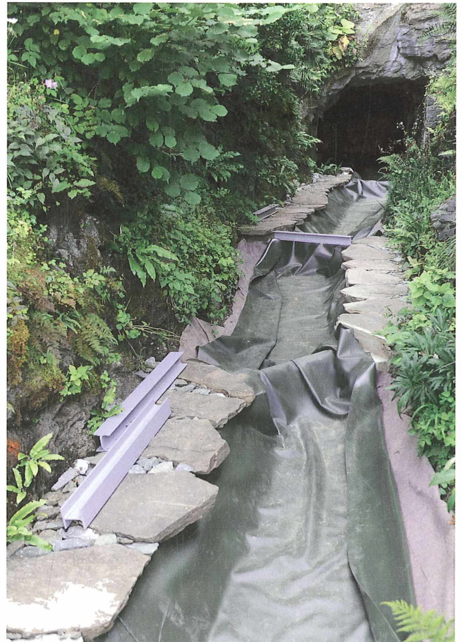
Abb. 10: Verlegung der Teichfolien für den Wasserlauf in der „Farnschlucht“ Aufn. R. K. Eberwein, LMK-KBZ
