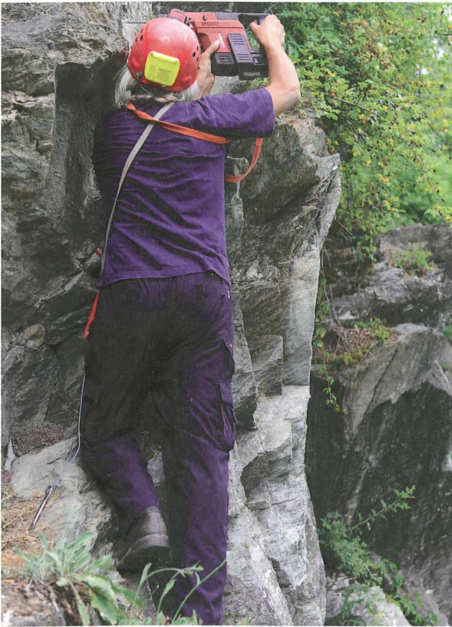
Abb. 7: Fels-Bohrungen zur Aufnahme einer besonderen Halterung für Bat-corder durch den Fledermaus-Spezialisten Harald Mixanig. Aufn. R. K. Eberwein, LMK-KBZ
