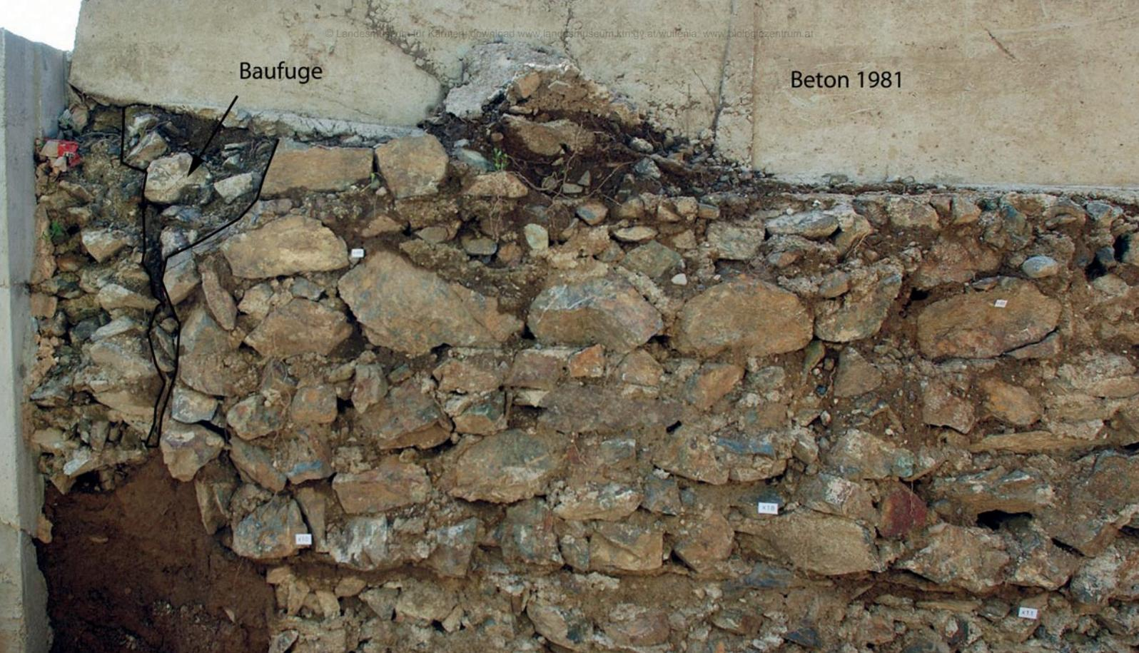
Abb. 7: Deutlich erkennbare Baufuge zwischen der Nordmauer von SH/6 und der Westmauer von SH/7. Aufn. Ch. Baur
