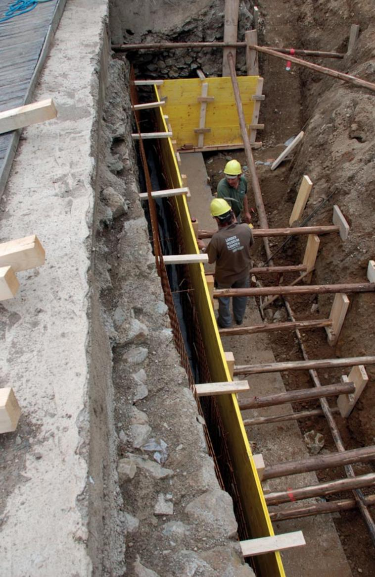
Abb. 3: Anbringung der Pfostenstützkonstruktion für die Schalung der Nordmauer von SH/7 aus Westen. Aufn. D. Ebner
