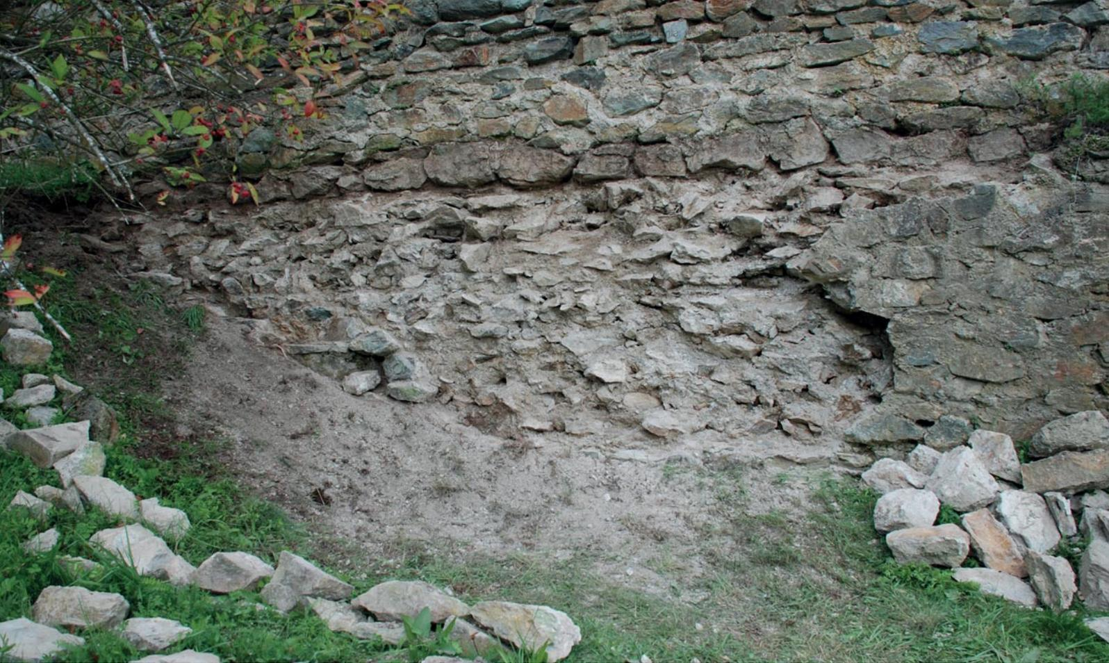
*Abb. 4: Östliche Mauer der Osthalle des Tempels mit Mauerschalenbruch vor der Sanierung. Aufn. Ch. Baur*
