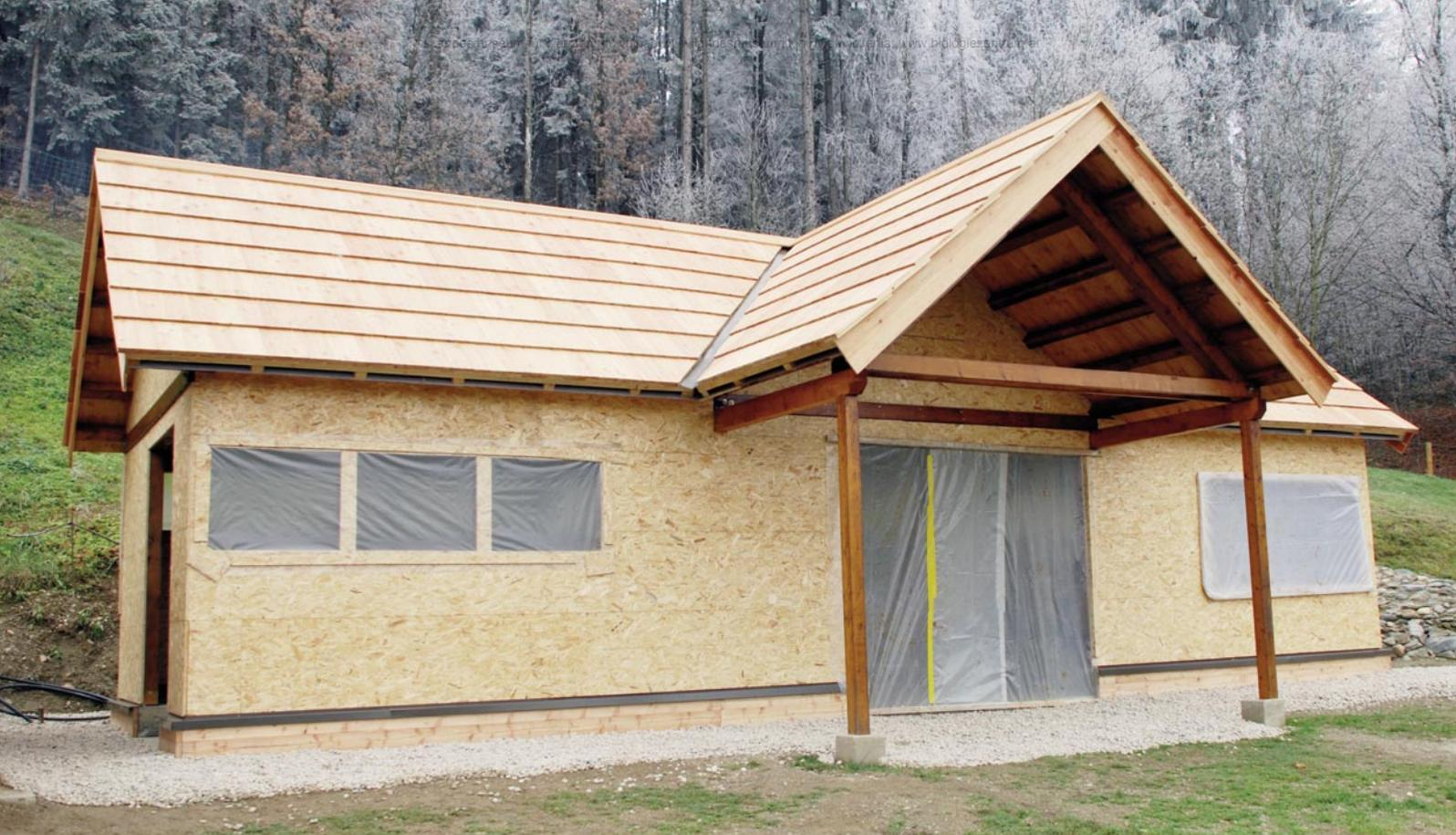
Abb. 8: Rohbau des Betriebsgebäudes mit Schindeldach und verplankten Außenwänden. Wintersicherung mittels PE-Folie. Blick aus Nordwesten. Aufn. R. Barlovits
