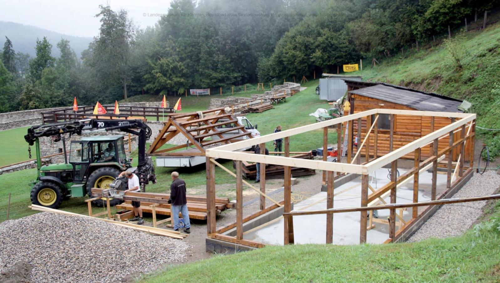
Abb. 6: Aufsetzen eines Dachgiebelements des ehemaligen Lapidariums Klagenfurt auf das Tragwerk des Betriebsgebäudes. Blick aus Südosten. Aufn. R. Barlovits
