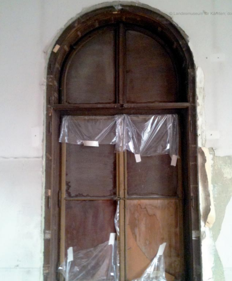
Abb. 25: Nach Abnahme der Reliefs der Brauttruhe der Paola Gonzaga und des Rückbaus der Ausstellungsarchitektur trat dieses „Fenster“ zum Vorschein. Statt Glasscheiben befanden sich darin dünne Pressspanplatten. Aufn. T. Jerger
