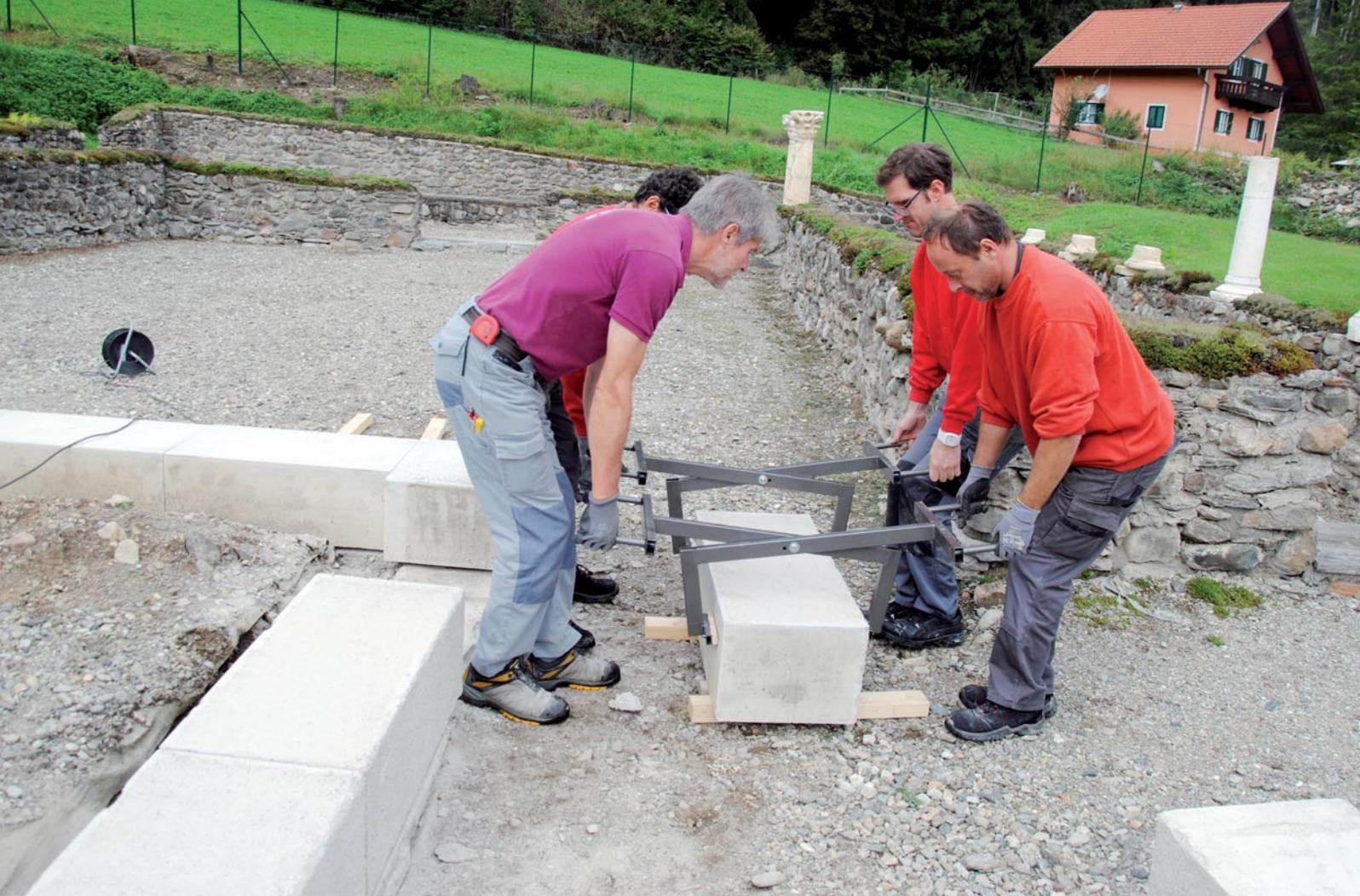
**Abb. 7:** Versetzen der Basisquader für die rekonstruierte Altarschrankenanlage in der Kirche extra muros. Aufn. F. Glaser
